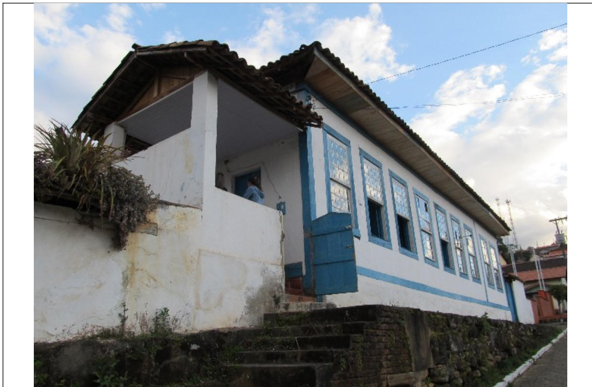
Figura 06- Casarão localizado na Praça Anísio Mendes da Fonseca, nº 68, em Alagoa, destacando seu alpendre lateral. Foto da vistoria realizada em 24/07/2012
