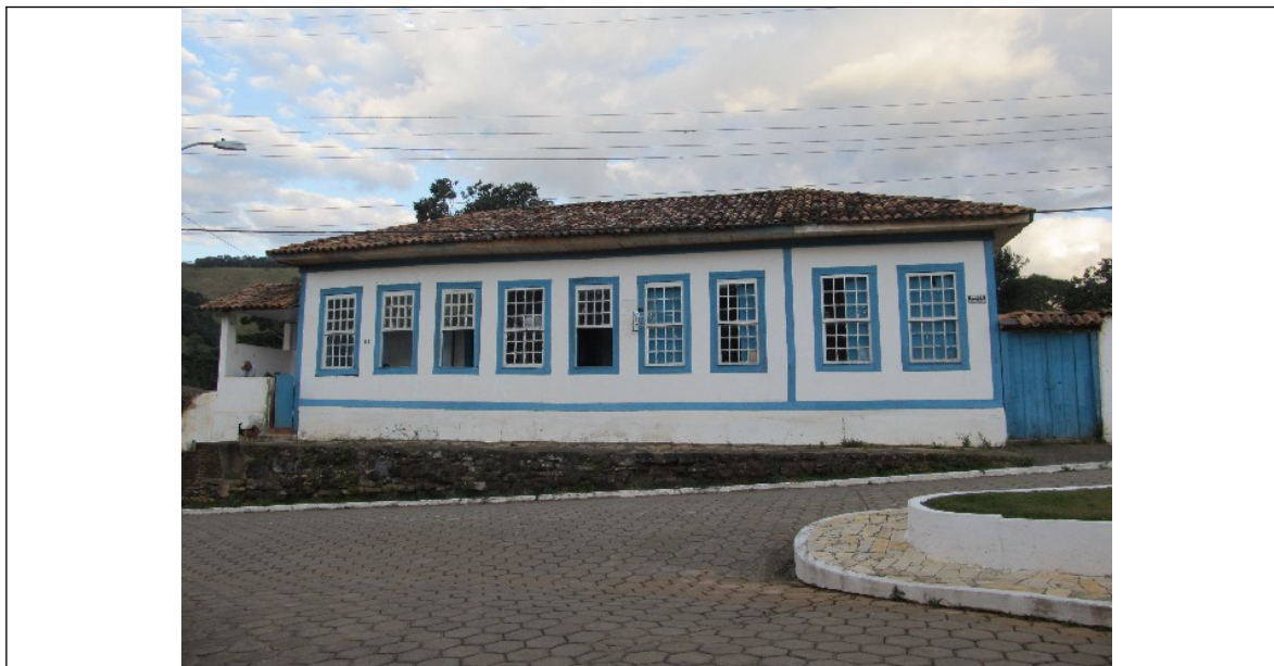
Figura 06- Casarão do sr. Levindo Pinto Mansilha em Alagoa. Foto da vistoria realizada em 24/07/2012
