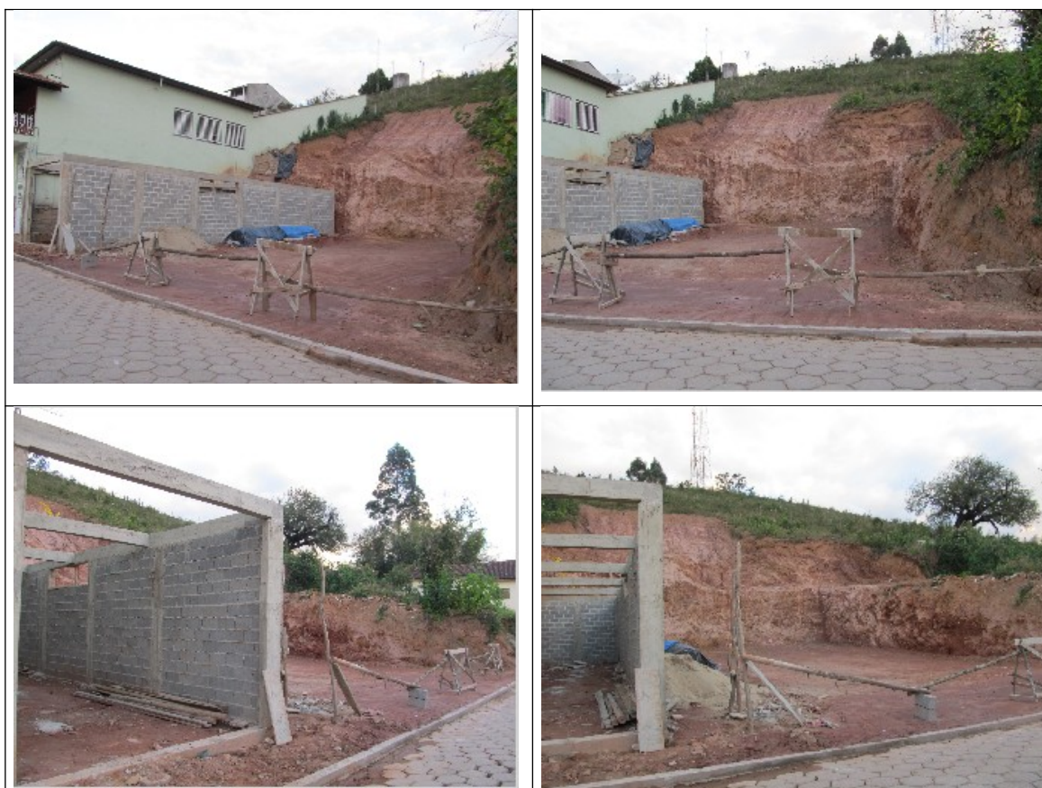
Figuras 05, 06, 07 e 08- Lote em obras na Rua Salvador Maciel Mendes em Alagoa.
