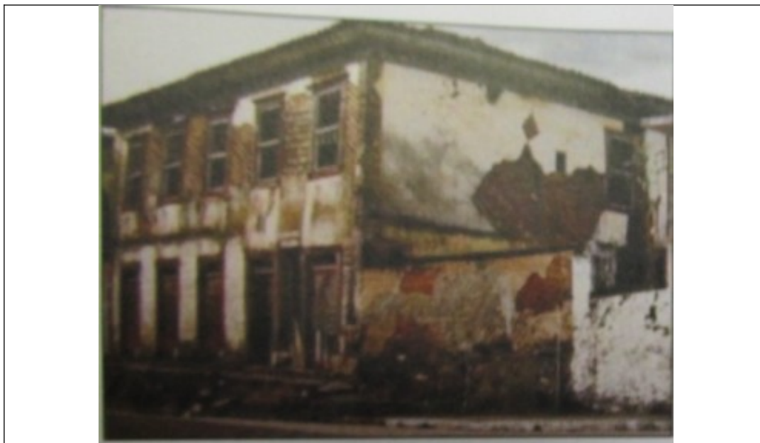
Figura 16- Imagem do casarão demolido na Rua Coronel Porfírio Mendes Pinto em Alagoa. Fonte: Plano de inventário do município, pesquisado junto ao IEPHA. O imóvel já aparecia como demolido neste Plano de Inventário.
