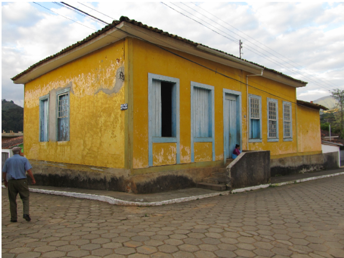
Figura 14- Casarão da Praça Anísio Mendes da Fonseca, nº 92 e “Seu Mironga” dirigindo-se à lateral do imóvel. Foto da vistoria de 24/07/2012.
