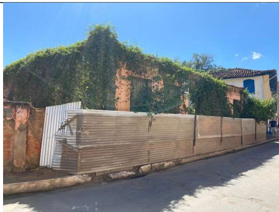
Figura 05 – Imóvel em julho de 2020.
