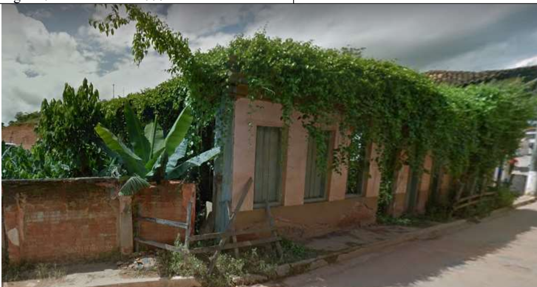
Figura 03 – Imóvel em dezembro de 2018.
