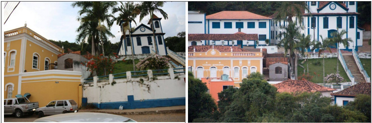
Figuras 03 e 04– Vista do imóvel e do anexo no conjunto tombado, 2015. Fonte: Arquivo Pessoal CPPC.
