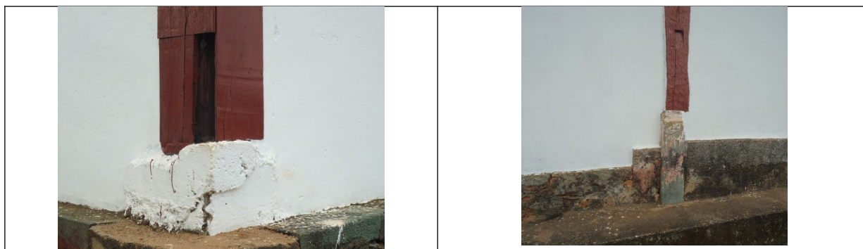
Figuras 12 e 13 – Pés de esteio substituído por concreto.
