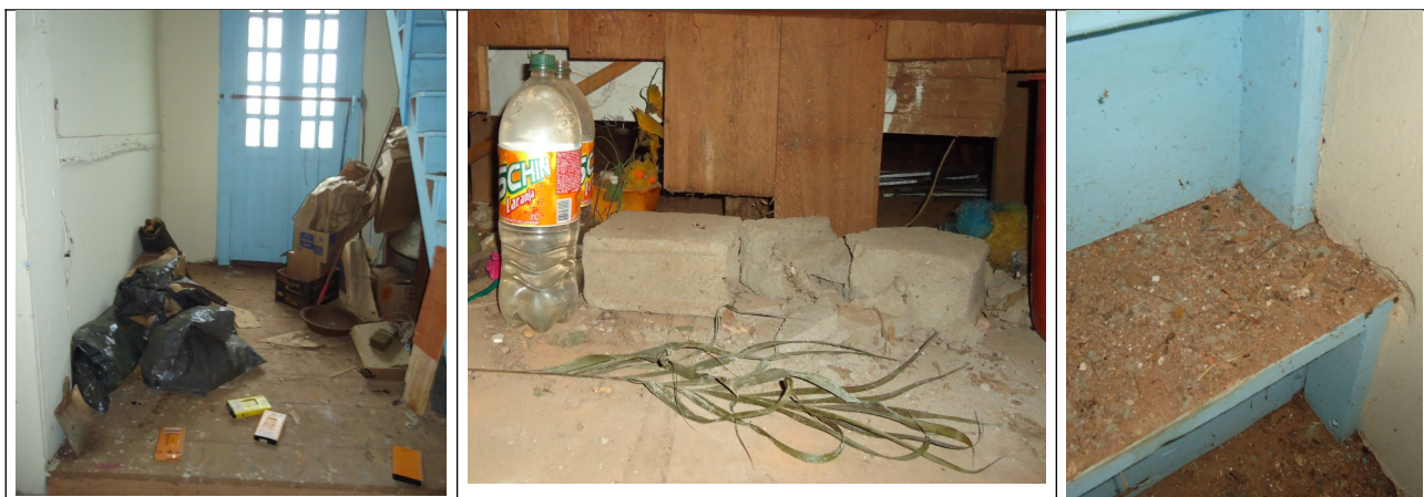
Figuras 09, 10 e 11 – Material armazenado debaixo da escada, e atrás do altar e sujeira dos animais.
