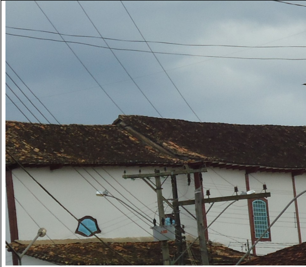
Figura 23 – Vista geral da cobertura.
