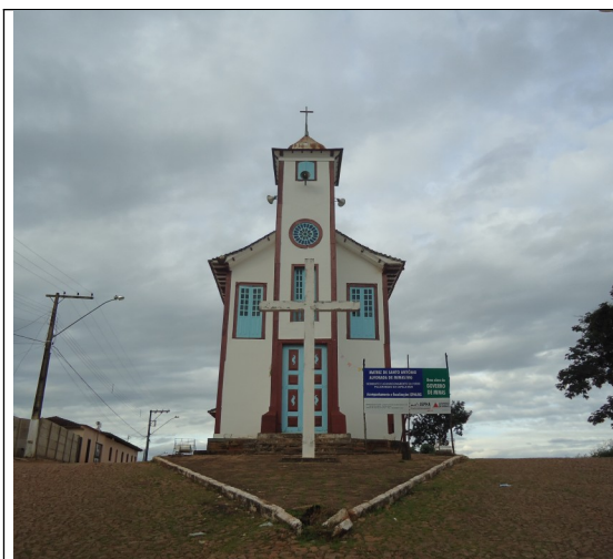
Figura 05 – Vista da fachada principal e do entorno.
