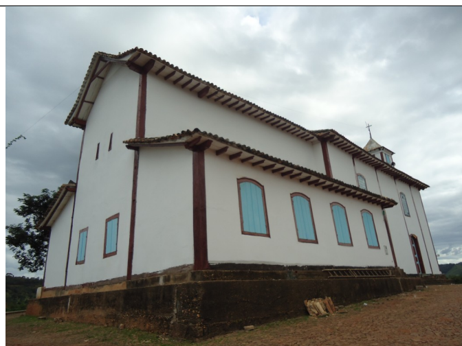
Figura 06 – Fachada lateral e de fundos.
