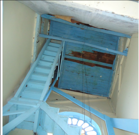
Figura 24 – Forro junto à escada de acesso a torre sineira.
