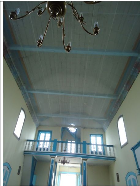
Figura 07 – Imagem interna da igreja onde se pode observar a tela de proteção instalada junto ao forro.
