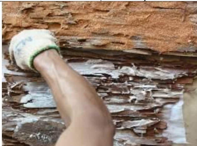
Figura 08 - Reforço estrutural dos pedaços de tábuas. Fonte: Grupo Oficina de Restauro.
