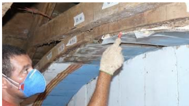
Figura 04 - Marcação nas cambotas e posicionamento das tábuas.
