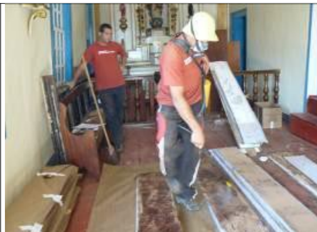
Figura 07 - Imunização das tábuas do forro a embalagem. Fonte: Grupo Oficina de Restauro.
