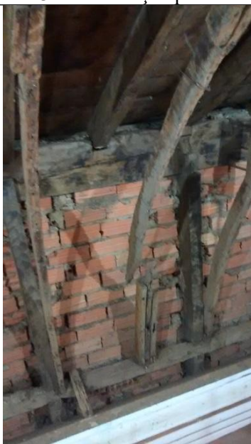
Figuras 14 e 15 - Vista das cambotas após o desmonte do forno e estrutura com novas cambotas. Fonte: Grupo Oficina de Restauro.
