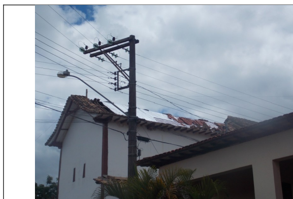
Figura 18 – Telhado sendo reformado.
