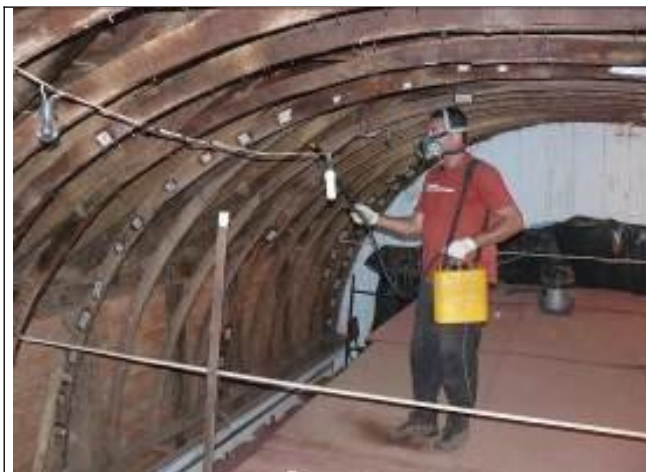
Figura 06 - Limpeza e imunização de estrutura o forro após o desmonte das tábuas. Fonte: Grupo Oficina de Restauro.
