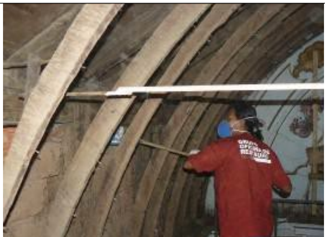
Figura 05 - Limpeza da estrutura o forro após o desmonte das tábuas.
