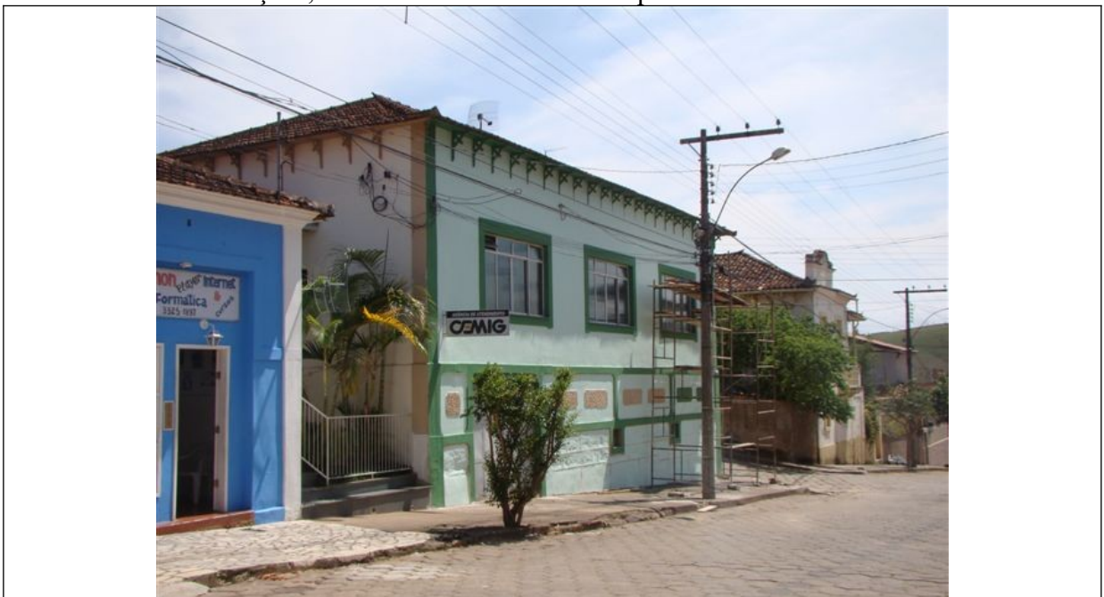
Figura 06 – Edificação em análise com a pintura relatada no memorial descritivo.
