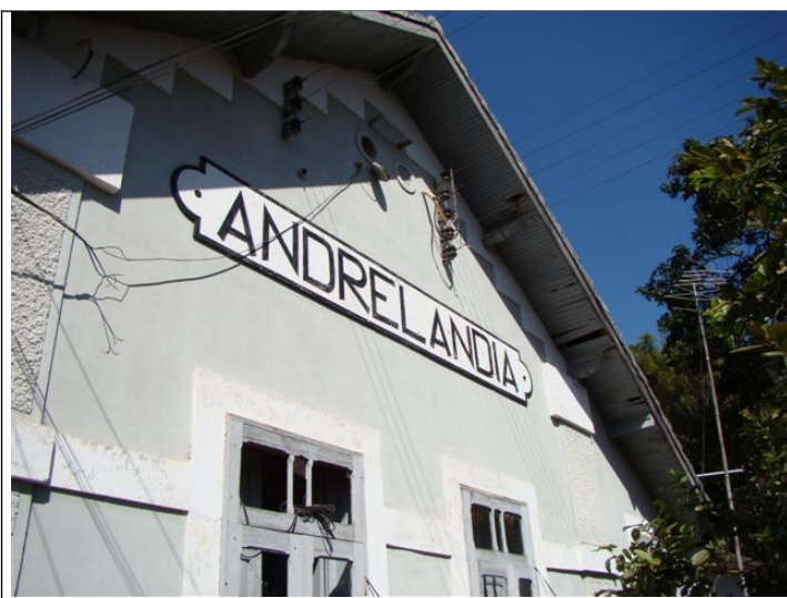
Figura 11 – Fiação exposta.
