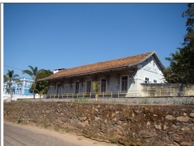
Figura 16 – Sujidades, fungos e plantas invasoras no embasamento de pedras.
