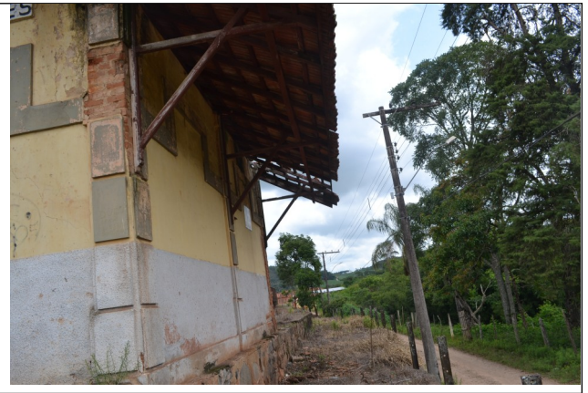
Figuras 03 e 04 – Fachadas da estação ferroviária, onde se verifica descolamento do reboco, danos na cobertura e fechamento de vãos com alvenaria..
