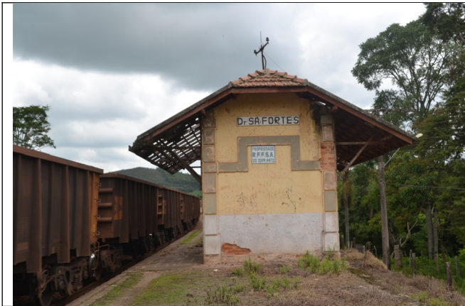
Figuras 03 e 04 – Fachadas da estação ferroviária, onde se verifica descolamento do reboco, danos na cobertura e fechamento de vãos com alvenaria..
