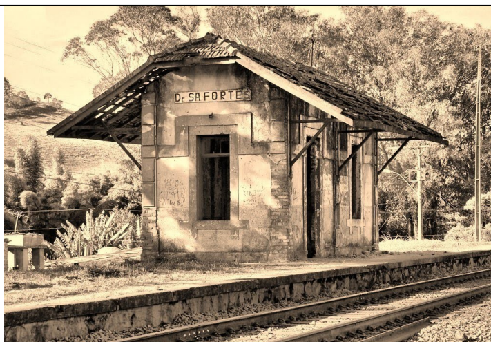
Figura 02 – A estação de Sá Fortes, em 03/2001. Foto Jorge A. Ferreira. Fonte: http://www.estacoesferroviarias.com.br
