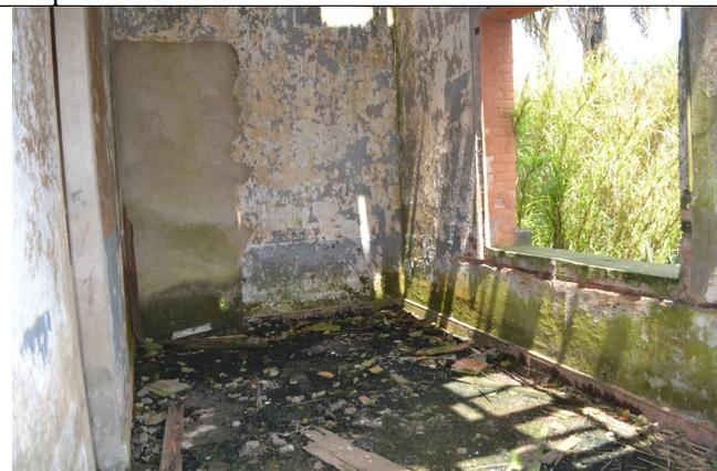
Figura 10 – Vista da párea interna da edificação, que apresenta descolamento da pintura, manchas de umidade, ausência de esquadrias e revestimento do piso.
