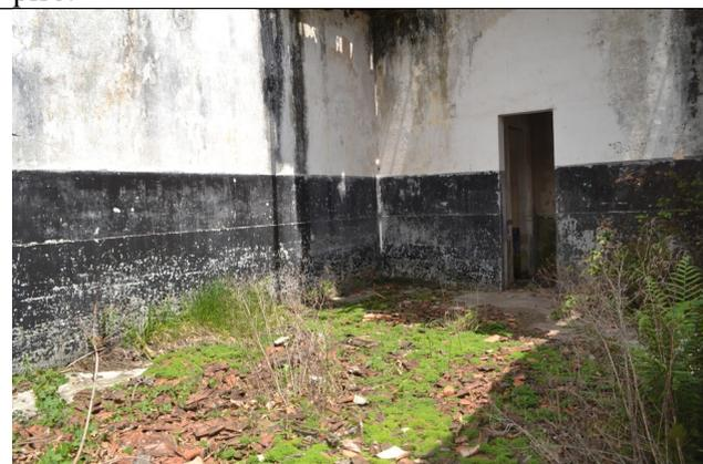
Figuras 12 e 13 – Aspecto interno da edificação, com manchas de umidade nas alvenarias, entulho e sujeira sobre o piso, ausência de cobertura e esquadrias.
