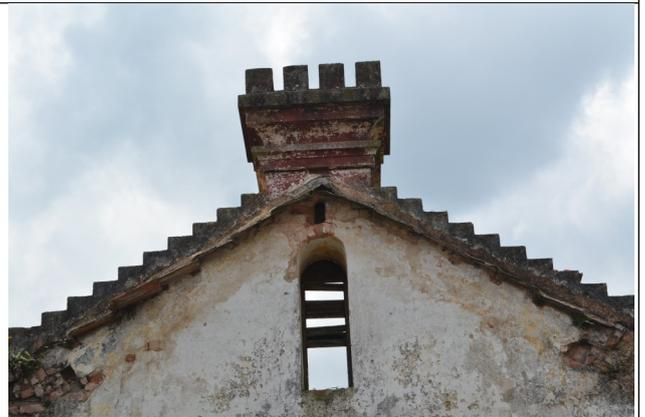
Figura 06 – Fachadas da estação ferroviária, onde se verifica descolamento da pintura, manchas de umidade, ausência de esquadrias, danos na cobertura e fechamento de vãos com alvenaria. Percebe-se o entorno tomado pela vegetação.
