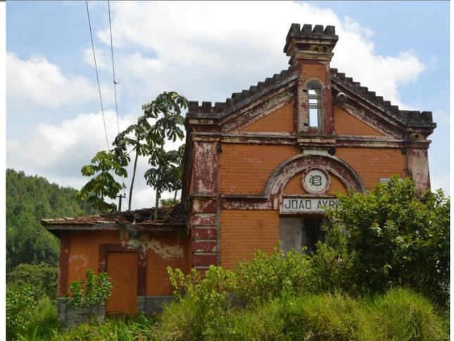
Figuras 04 e 05 – Fachadas da estação ferroviária, onde se verifica descolamento da pintura, manchas de umidade, ausência de esquadrias, danos na cobertura e fechamento de vãos com alvenaria. Percebe-se o entorno tomado pela vegetação.
