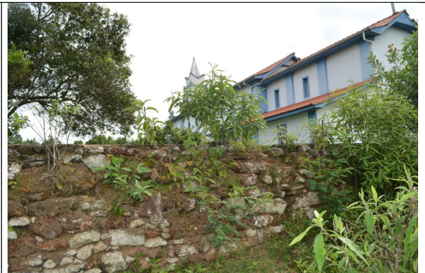
Figura 05 – Nota-se muro de pedra que foi identificado nas laterais e no fundo do templo de Nossa Senhora do Rosário.
