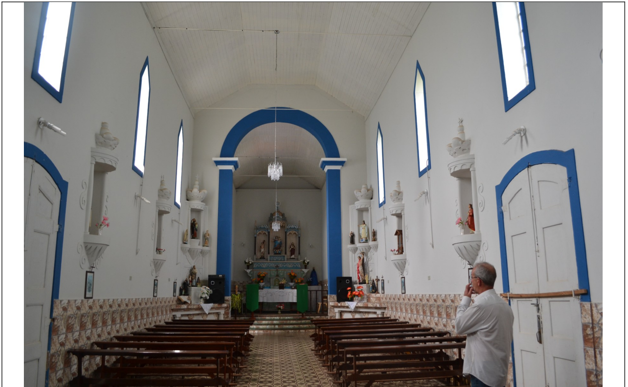
Figura 09 – Nota-se o revestimento na parte de baixo das paredes. Também é possível verificar que todo o interior do templo foi pintado de branco, com exceção dos batentes das portas e janelas e do arco-cruzeiro.
