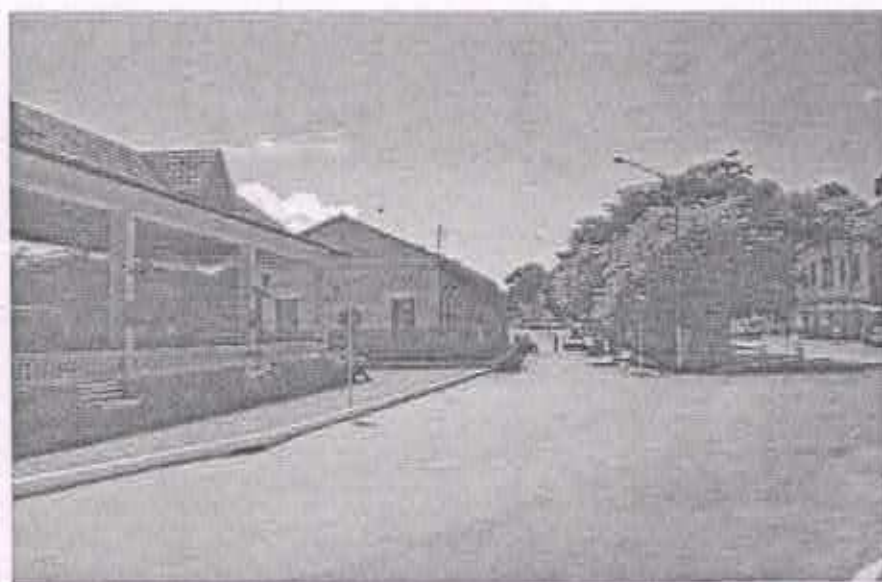
Foto 03 (12/12/2007) Ao fundo vista da antiga Estação Ferroviária de Sítio, atual Município de Antônio Carlos. Autoria: Kelly Lima
