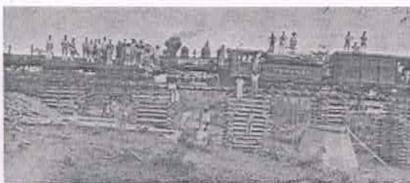
American de Lastro trabalhando nas obras da linha para Monte Azul em 1944
