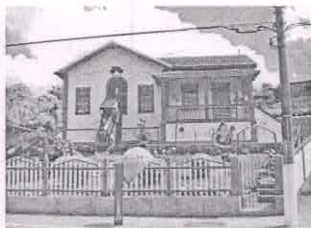
Foto 07 – Distrito Sede Antiga Casa do Agente Ferroviário – Atual Casa de Cultura. Fotografia: Kelly Lima – dez/2007
