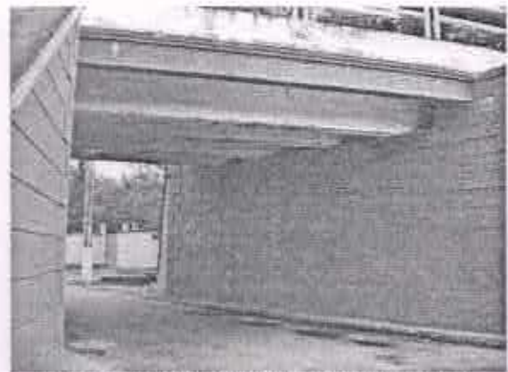
Vista da estrutura inferior, metálica, do viaduto.
