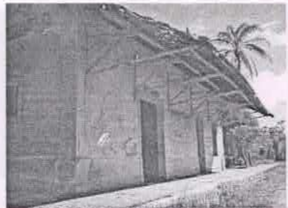
Vista da área de embarque e desembarque da Estação.
