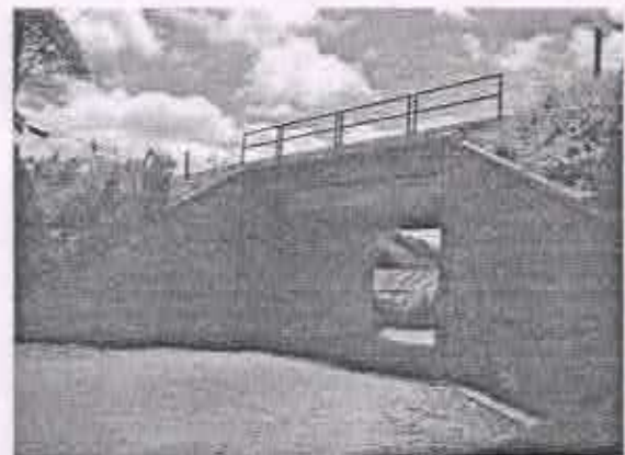
Vista do Viaduto de Sá Fortes.
