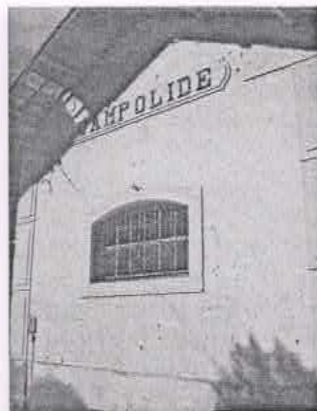
Vista da fachada Lateral da Estação de Campolide.
