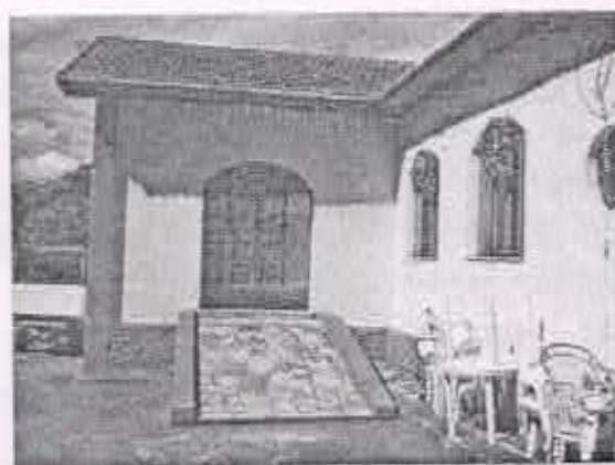
Fachada lateral direita da Casa da Cultura.
