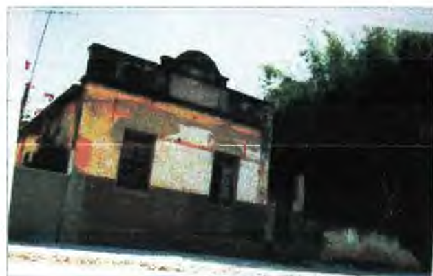
Fotografia do Asilo antigo, antes da demolição e inauguração do novo prédio, em 1999. Acervo: Claudiney Meneses Santana
