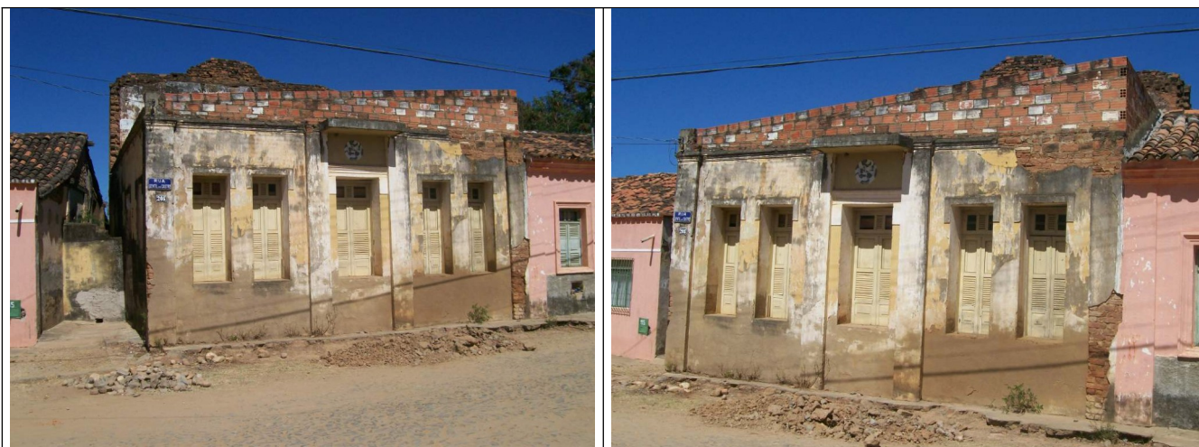
Figuras 07 e 08 – Fachada frontal do imóvel.
