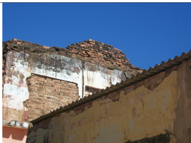
Figura 12 – Alvenaria remanescente do segundo pavimento, que foi demolido.
