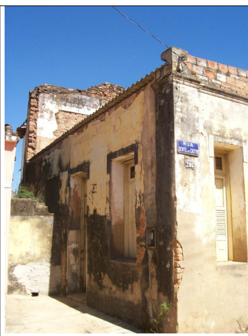
Figura 10 – Fachada lateral esquerda.
