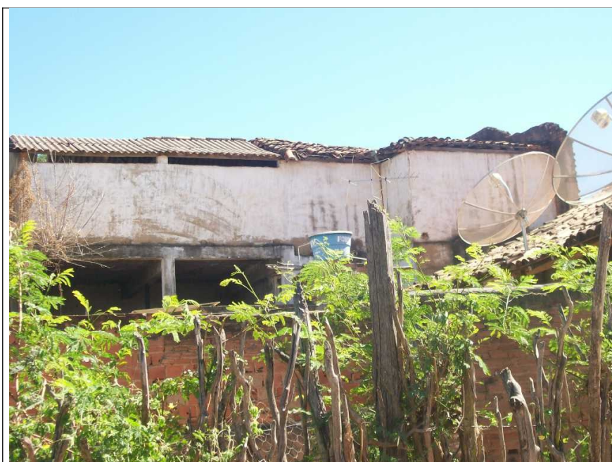
Figura 09 – Acréscimo nos fundos da edificação.
