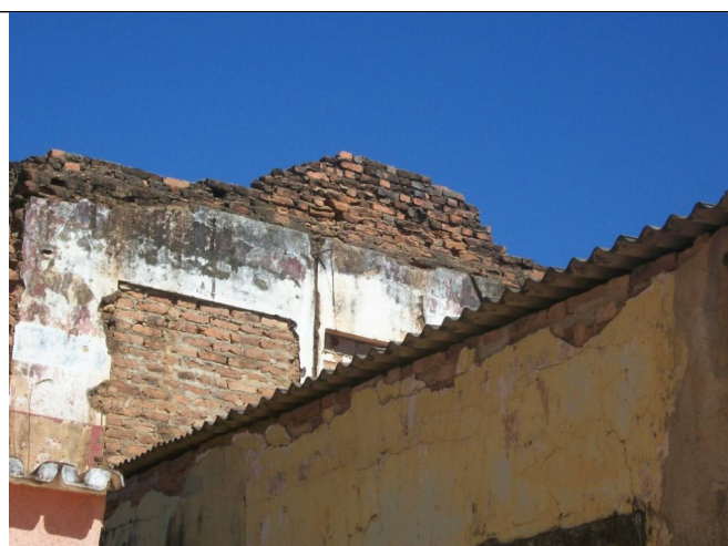
Figura 14 – Alvenaria remanescente do segundo pavimento, que foi demolido.
