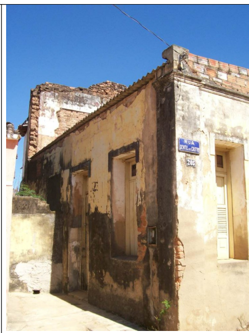
Figura 12 – Fachada lateral esquerda.
