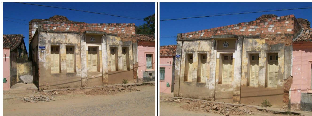
Figuras 09 e 10 – Fachada frontal do imóvel.
