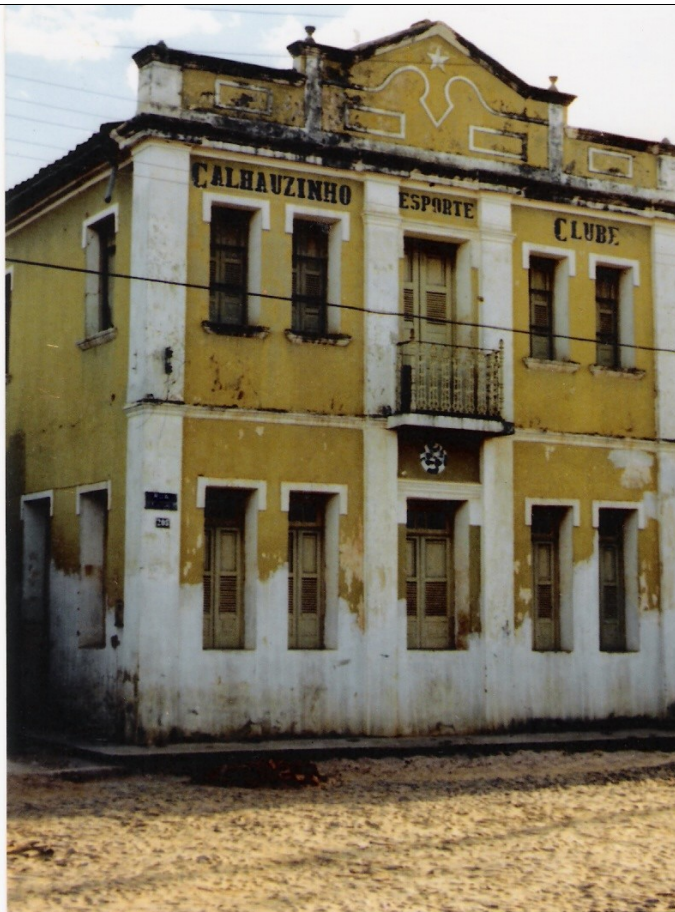
Figura 08 – Imagem do Clube Calhauzinho antes da demolição do segundo pavimento.
