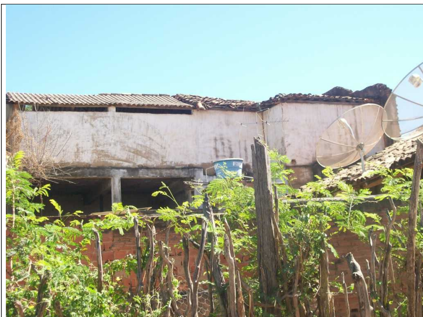
Figura 11 – Acréscimo nos fundos da edificação.
