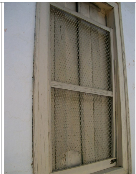
Figura 12 – Tela metálica junto à esquadria.
