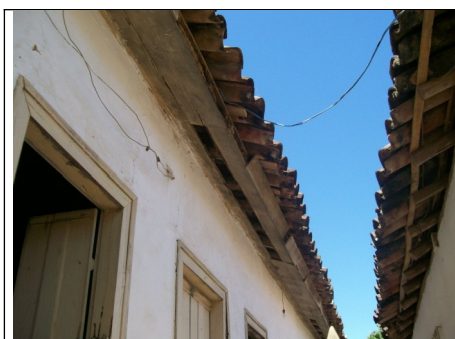
Figura 13 – Fiação exposta.
