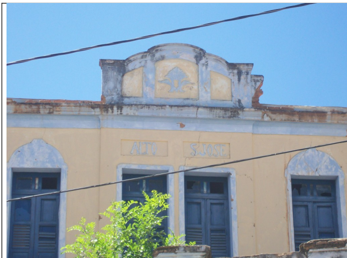
Figura 08 - Platibanda em processo de arruinação e inscrição em massa “Alto S. José”.
