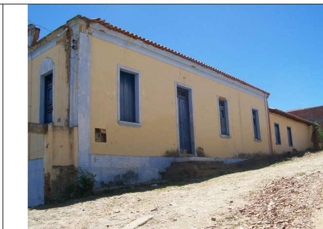
Figura 07 – Fachada lateral direita.
