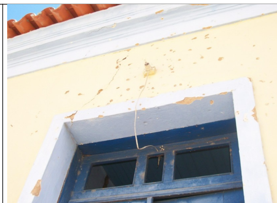
Figura 12 – Fiação exposta.
