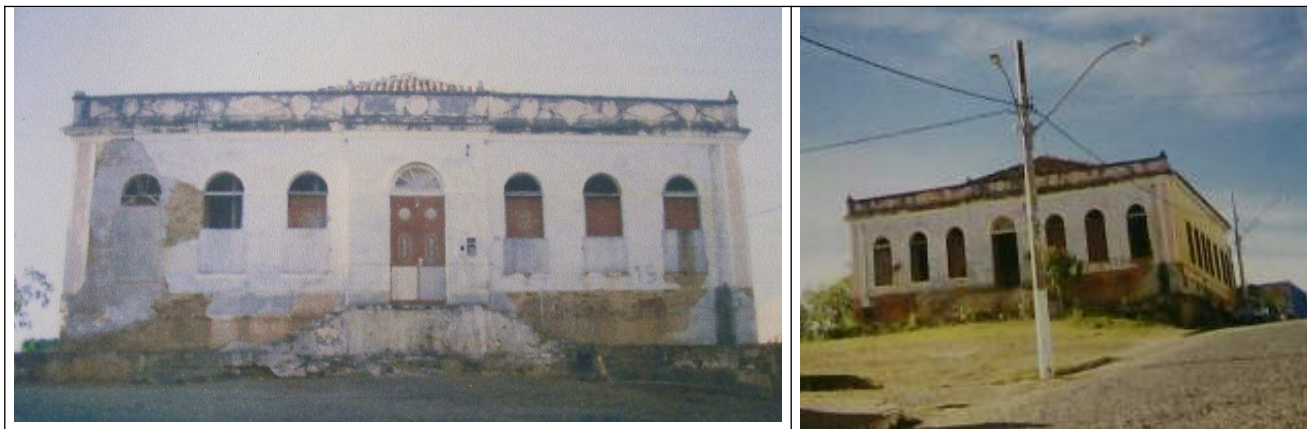
Figuras 06 e 07 – Imagens antigas da edificação.
