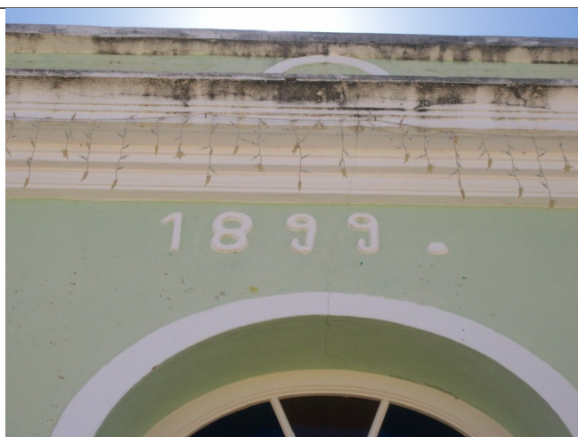
Figura 09 – Inscrição em massa com a data da construção.
