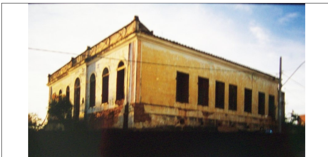
Figura 05 – Imagem antiga da edificação.
