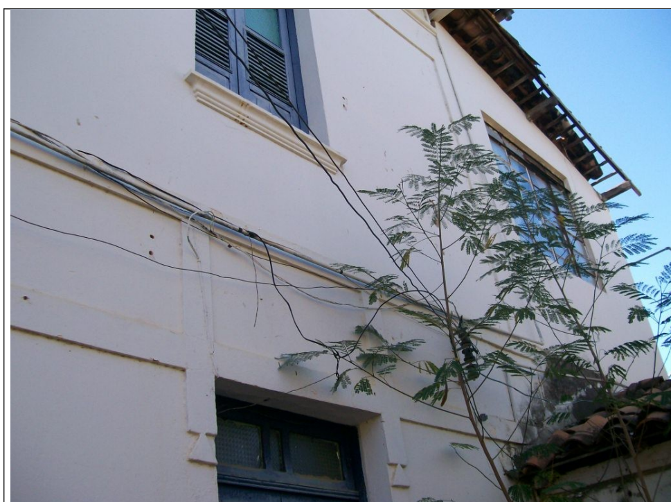
Figura 14 – Fiação exposta.
