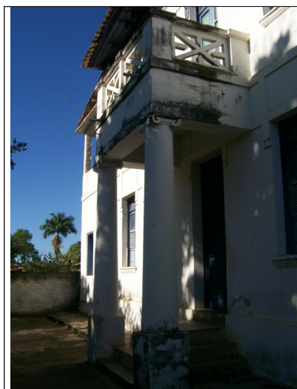
Figura 09 – Fachada lateral de acesso à edificação
