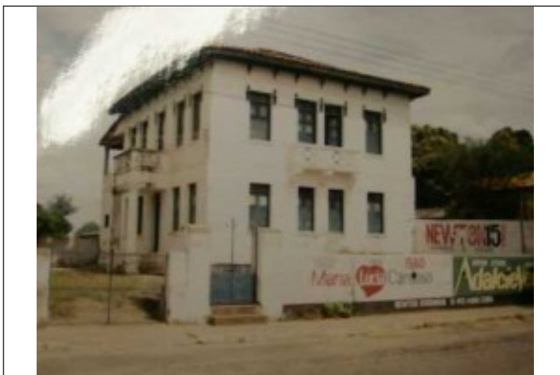
Figura 07 – Imagem antiga da edificação.
