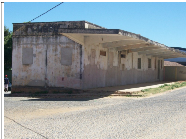
Figura 08 – Fachada dos fundos.
