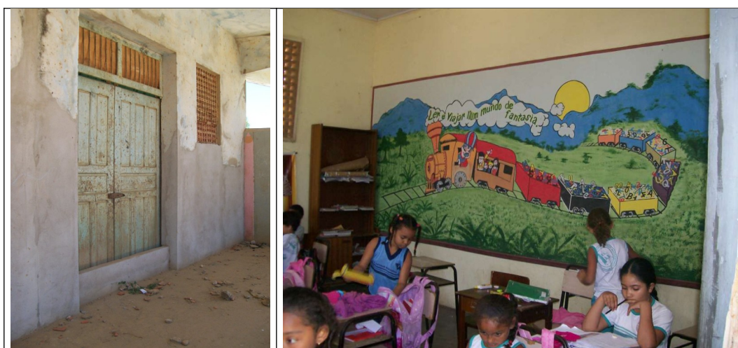
Figura 13 – Porta original com vedação de alvenaria junto à base.
