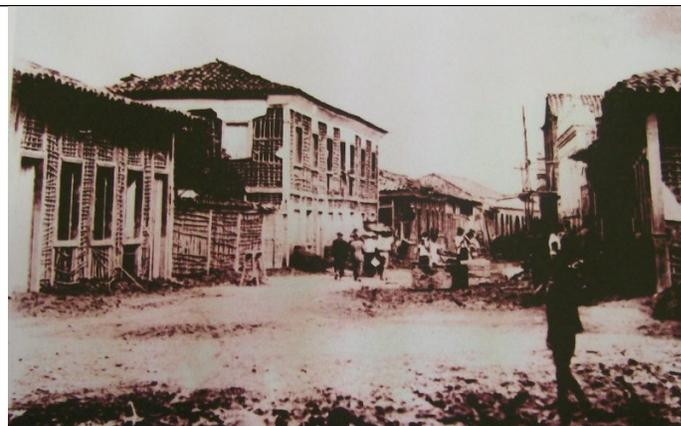
Figura 08 – Rua Gentil de Castro aos a enchente de 1979. Verifica-se a trama das alvenarias em pau a pique.
