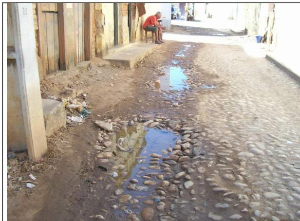
Figura 21 – Pavimentação com pedras “calhau” com desnivelamentos e pedras soltas.
