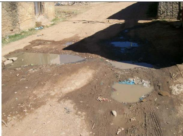
Figura 22 – Falta de pavimentação e de drenagem. Esgoto a céu aberto.
