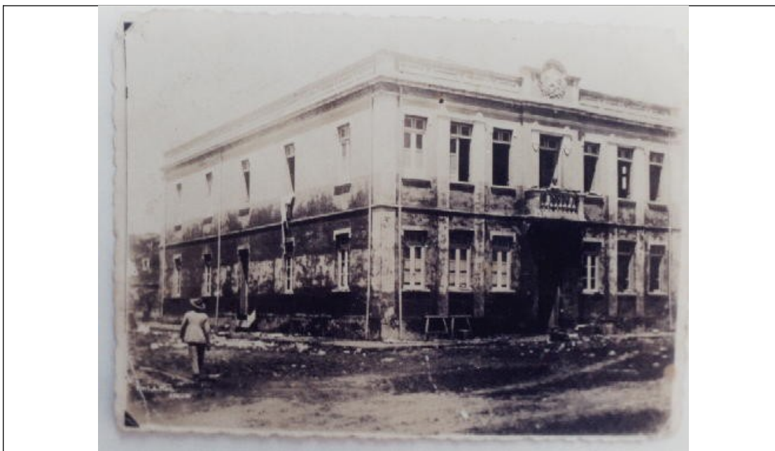
Figura 06 – Imagem antiga da edificação.
