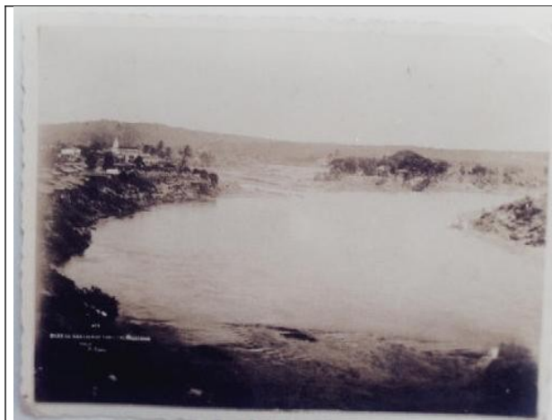
Figura 02 – Fotografia antiga – Porto do Rio.
