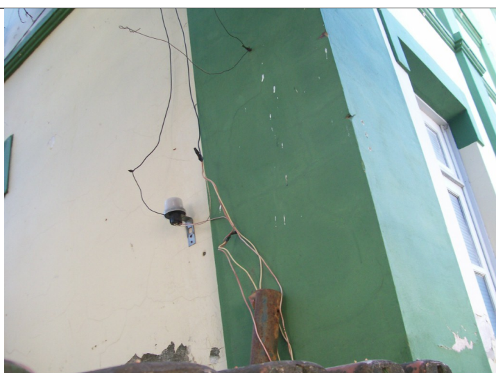
Figura 10 – Fiação exposta.
