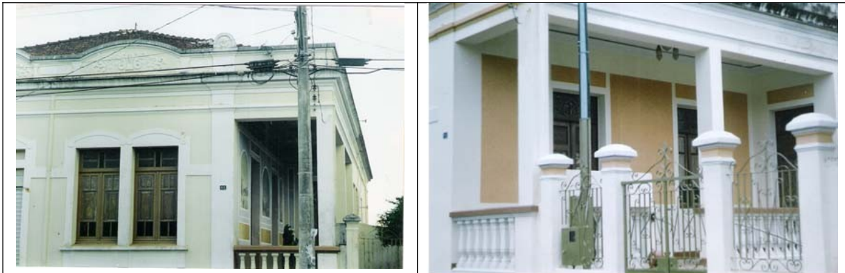
Figuras 16 e 17 – Fotos do alpendre da parte residencial com as pinturas parietais e de ferro (à esquerda em 2002) e sem as pinturas, após intervenção (à direita em 2007).
