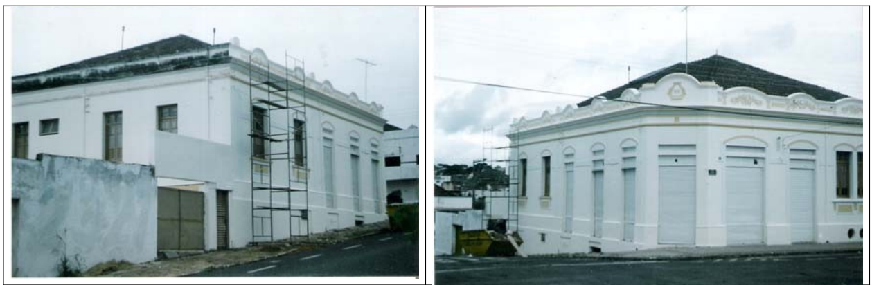
Figuras 14 e 15 – O imóvel em reforma em 2007.
