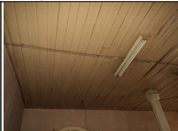
**Foto 15:** Forro em madeira com a presença de fiação exposta.
