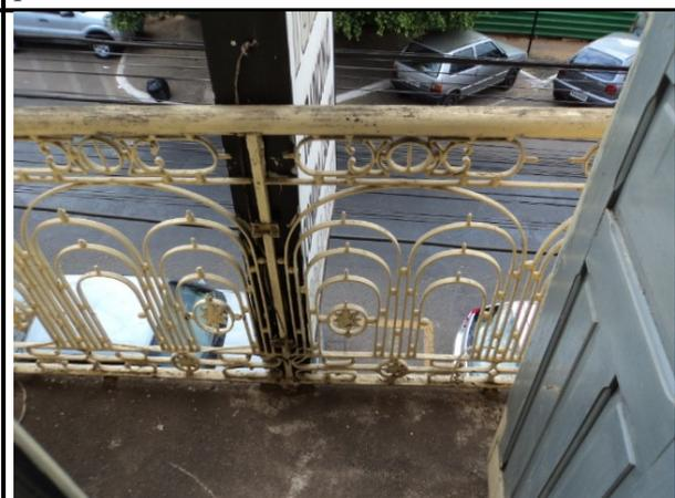
**Foto 25:** Sacada em ferro moldado no segundo pavimento.
