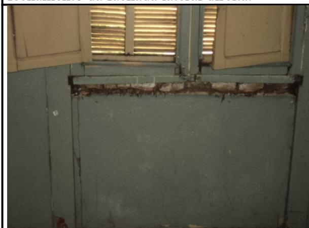
**Foto 24:** Substituição do peitoril em ferro por alvenaria na janela do segundo pavimento.
