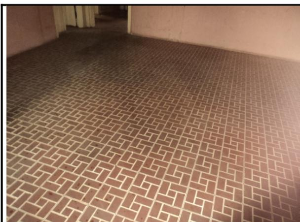
**Foto 10:** Piso em ladrilho hidráulico instalado há aproximadamente 70 anos apresentando algumas peças danificadas.
