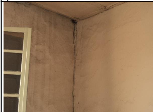
**Foto 22:** Trinca existente na alvenaria de fechamento da fachada lateral direita.
