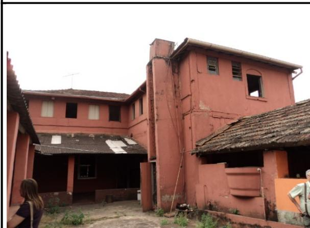
**Foto 06:** Fachada posterior da edificação com a inserção de anexos. Observar vidros de janelas quebrados e sujidades na alvenaria.
