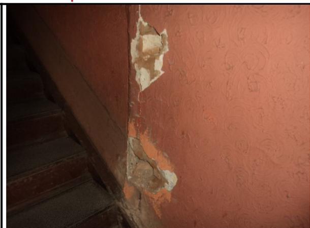
**Foto 21:** Descolamento do revestimento da alvenaria.
