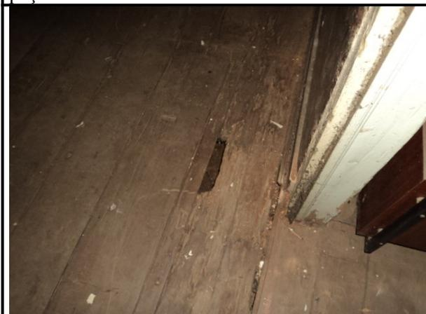
**Fotos 12 e 13:** Piso em tabuado corrido danificado pela ação de insetos xilófagos com peças “soltas” e desgastadas.
