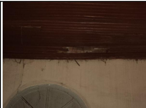
**Foto 14:** Forro em madeira apresentando abaulamento e com réguas danificadas.
