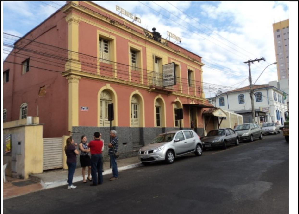
**Foto 01:** Imagem da edificação no momento da vistoria. Observar alterações na fachada principal principalmente das portas e janelas, bem como portão lateral.
