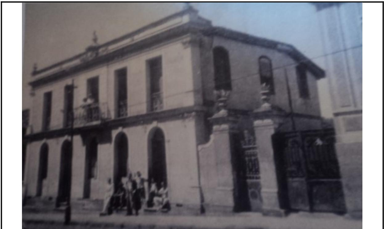
**Figura 08:** Fachada original da edificação com a presença das portas no primeiro pavimento e janelas rasgadas com peitoril de ferro moldado no segundo. Observar a existência de sacada e portão lateral. Esta imagem foi retirada do arquivo da Sra. Priscila Brito Evangelista.
