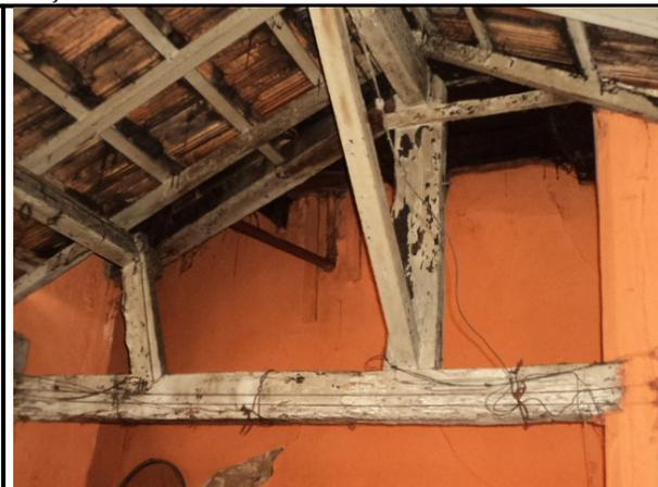
**Foto 19:** Observar fiação exposta na madeira da estrutura do telhado.
