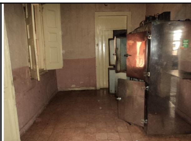
**Foto 11:** Piso em cerâmica desgastada e com peças danificadas.
