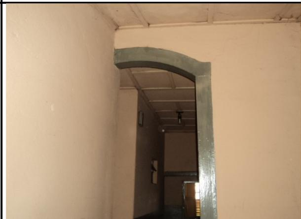
**Foto 23:** Construção de alvenaria dividindo o portal da abertura.
