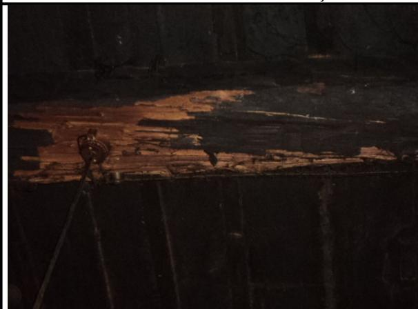
**Foto 18:** Viga em madeira deteriorada pela ação de insetos xilófagos.
