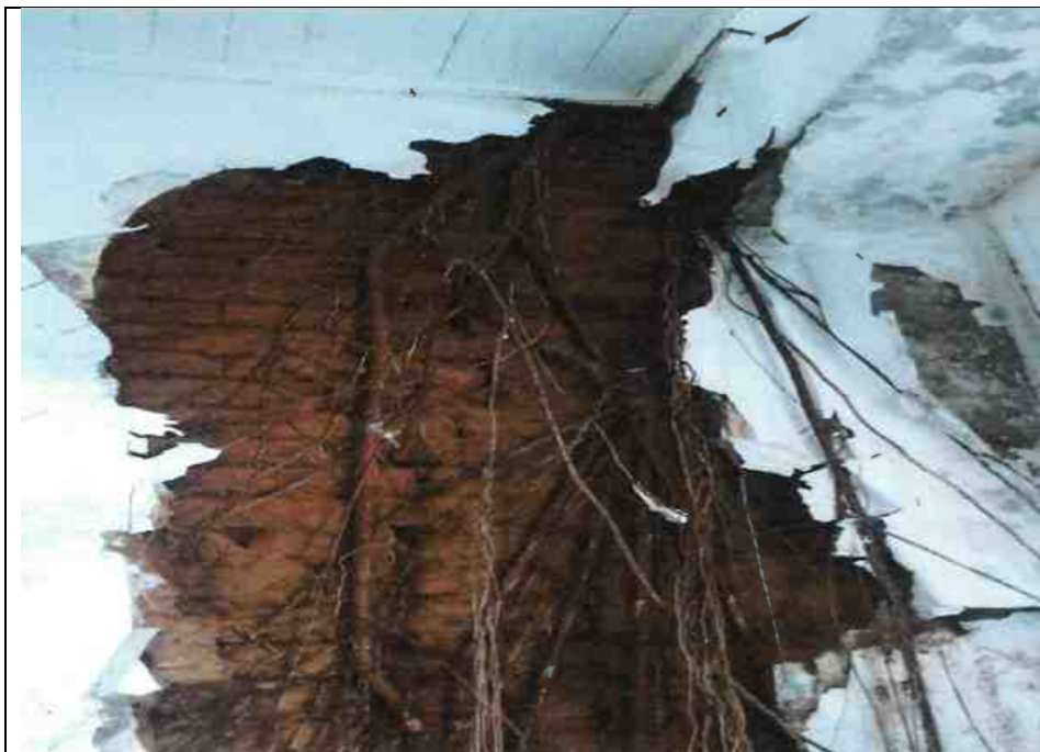
Figura 07 – Imagem da raiz da árvore nas alvenarias do imóvel. Fonte: Laudo juntado nos autos.
