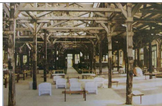
Figura 08 – Vista interna do edifício da fábrica.
