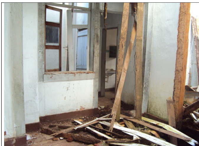
Figura 11 – Interior da edificação.
