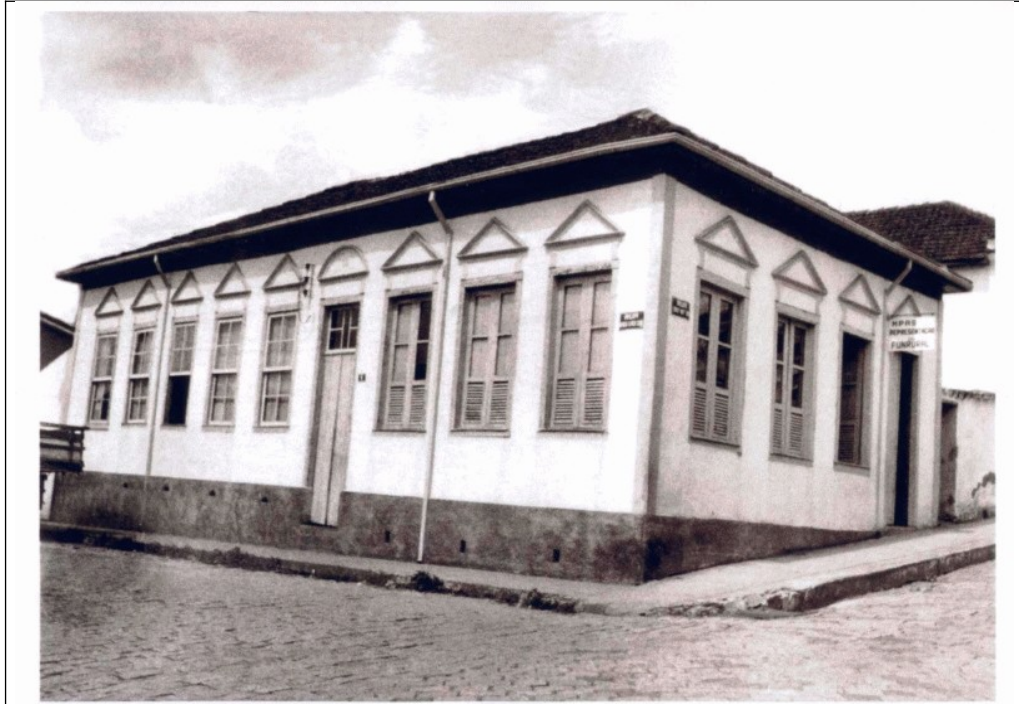
Figura 03 - Fachadas da edificação.
