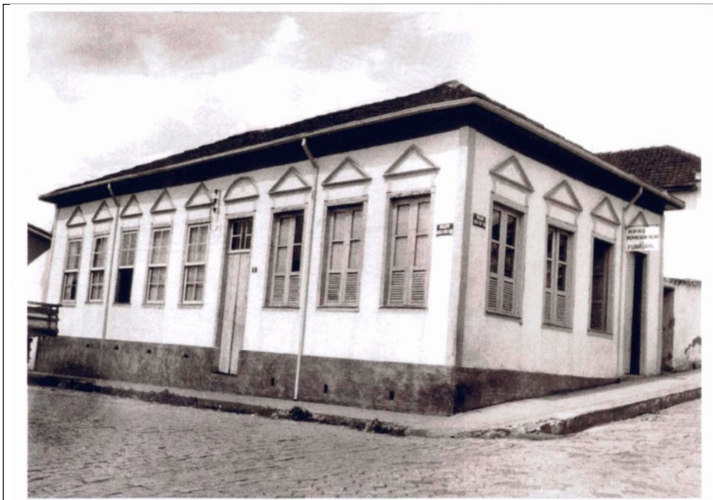
Figura 03 - Fachadas da edificação.
