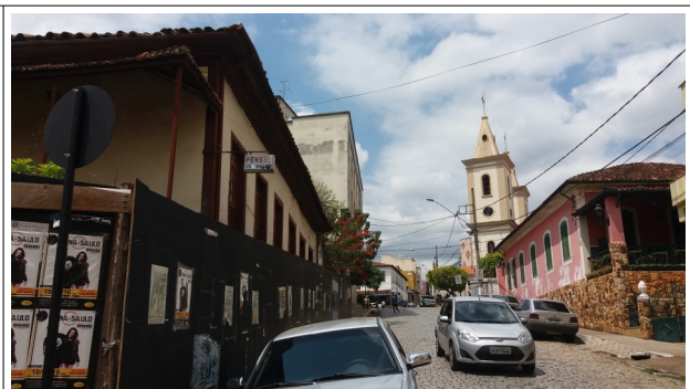
Figura 18 – Rua em que se insere o imóvel em análise, com igreja nos fundos
