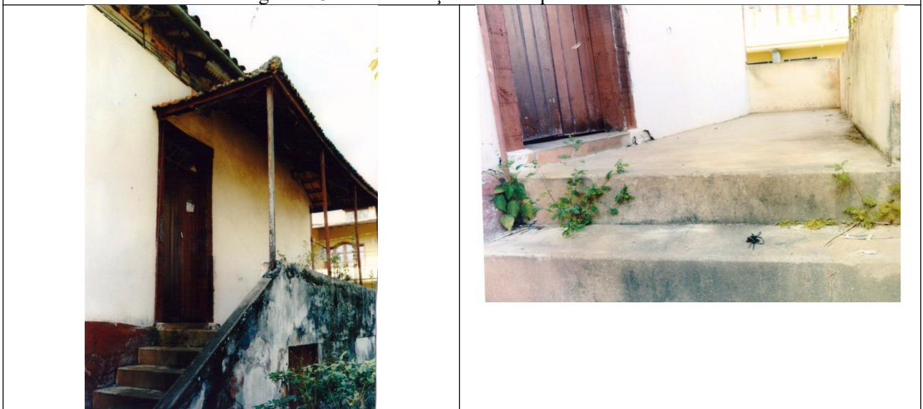
Figuras 15 e 16- Situação atual parte externa.
