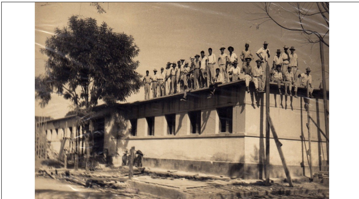
Figura 11 – Homens trabalhando na construção de um dos pavilhões da antiga colônia São Francisco de Assis. Fonte: foto enviada por e-mail pelo Núcleo de Ensino e Pesquisa da Casa de Saúde São Francisco de Assis. Acesso em: 20-02-2017.
