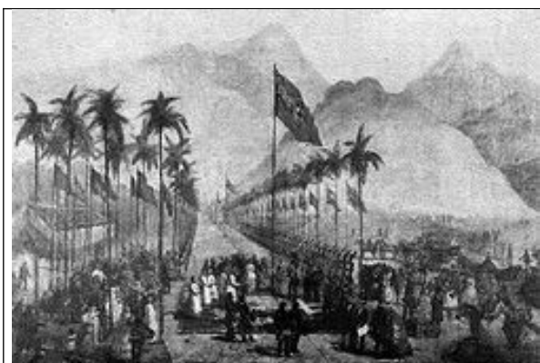
Lançamento da pedra fundamental da E.F. Mauá.
