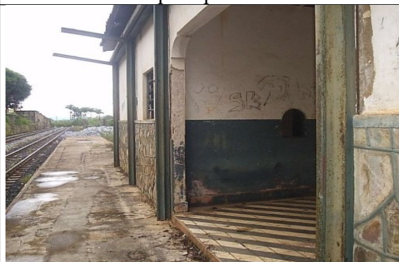
Plataforma, vendo-se a bilheteria, em 02/2007. Fonte: Foto Diovanni Resende apud 8
