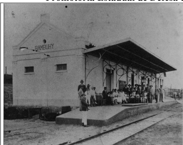
A estação, provavelmente década de 1920. Fonte: Acervo do Arquivo Municipal/cessão Andila A. Carvalho apud 8
