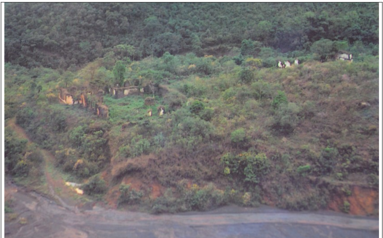
Figura 09- Vista da colina onde se assentavam os principais prédios da mina de Gongo Soco. À esquerda, a Casa da Mina e ao fundo, à direita, o prédio do almoxarifado. Fotografia de 1991, pesquisada junto ao IEPHA.
