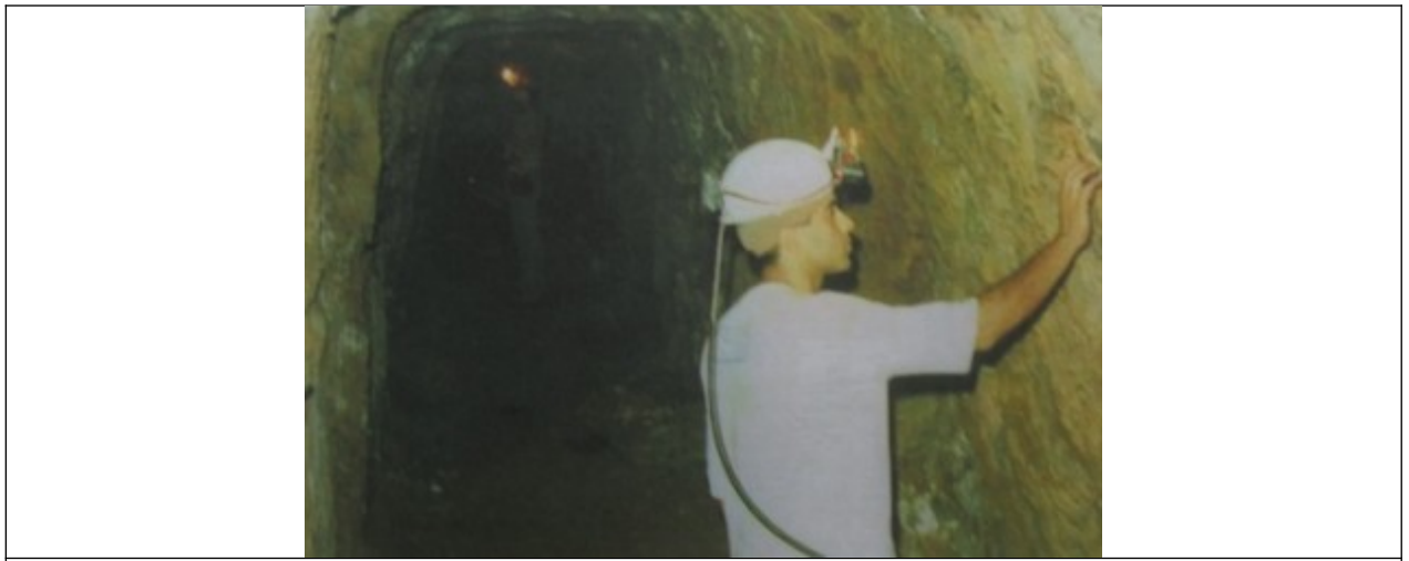
Figuras 13 e 14- Galeria em Gongo Soco. Fonte: Relatório Final- Registro Fotográfico- Ruínas de Gongo Soco- Setor Industrial.
