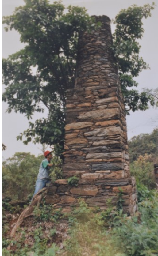
Figura 19- Antiga chaminé, construída em 1828. Fotografia pesquisada junto ao IEPHA, na qual consta a seguinte informação: “Apresentava formato quadrado na base e na metade inferior, tornando-se cilíndrica na porção superior. A altura do conjunto era de 5 m”.
