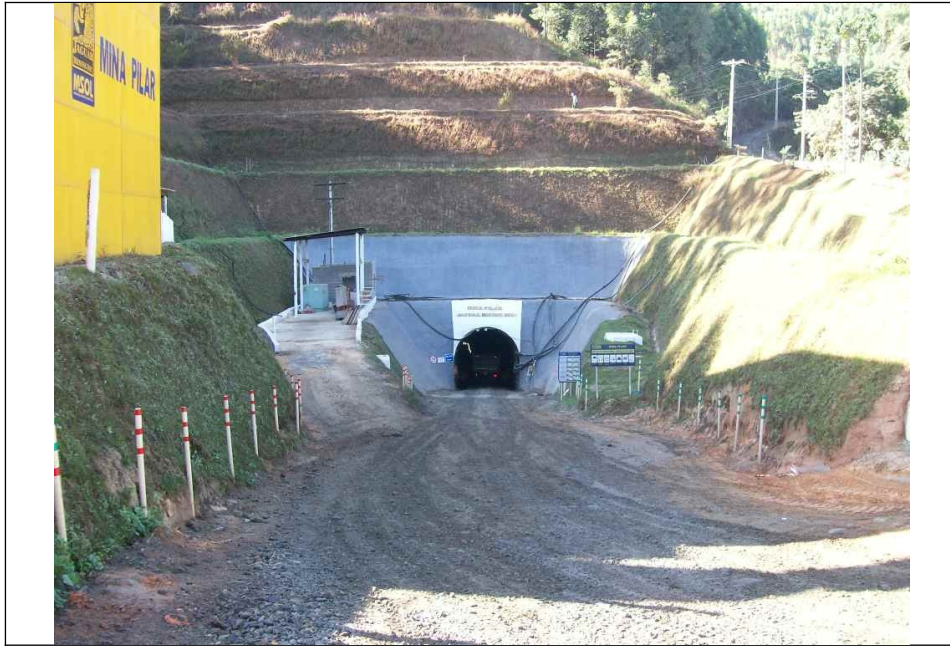
Foto 1 – Entrada da mina subterrânea no empreendimento Mina Pilar.
