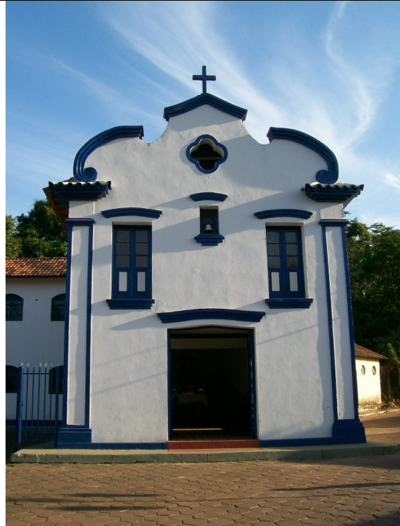
Foto 16 – Capela de Santo Antônio, localizada nas proximidades da Rua Afonso Pena.
