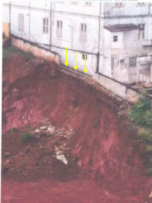
Figura 4: As setas mostram o passeio lateral do Solar dos Bias na divisa com a obra que foi vistoriado pela CEAT Engenharia. Fonte: Notificação extrajudicial, fl. 06 dos autos.
