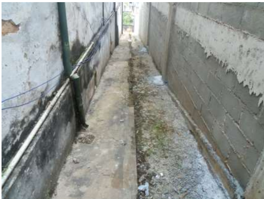
Figura 6: Nota-se ausência de trincas, rachaduras e abatimento do passeio lateral do imóvel Solar dos Bias, na divisa com a obra.
