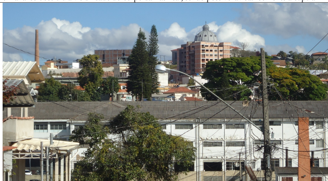
Figura 07 - Imagem a partir da rua Tenente Alípio Serpa, bairro Andaraí.. Verifica-se que a construção em análise obstruiu a visibilidade do corpo da Basílica, sendo possível avistar somente a cúpula.
