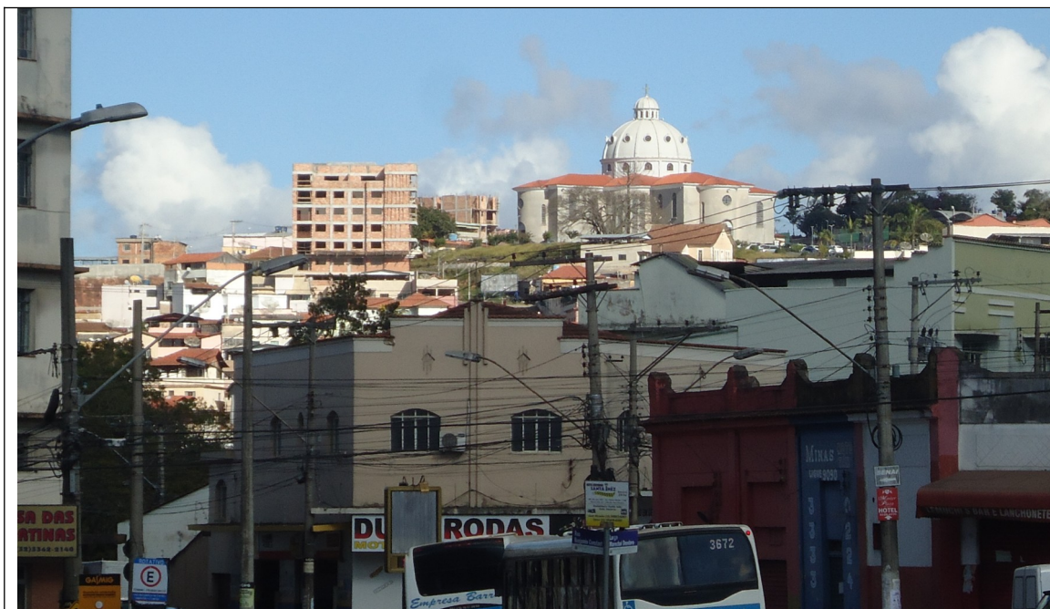
Figura 08 - Imagem a partir do Largo Marechal Deodoro, bairro Centro. Verifica-se que a construção em análise compete com a Basílica como elemento de destaque e referência na paisagem urbana.
