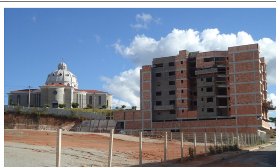
Figura 03 - Imagem atual da edificação, com 8 (oito) pavimentos construídos e início do emboço das alvenarias.
