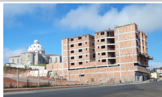
Figura 02 - Imagem da edificação em julho de 2018, com 7 (sete) pavimentos construídos.
