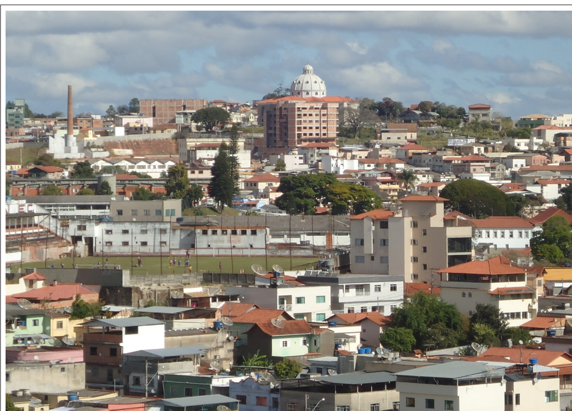
Figura 05 - Imagem a partir da Rua Sargento Orlando Passos, bairro Santa Efigênia. Verifica-se que a construção em análise obstruiu a visibilidade do corpo da Basílica, sendo possível avistar somente a cúpula.
