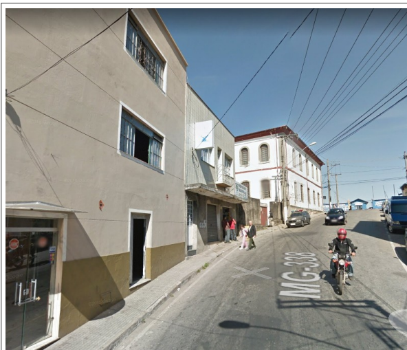
Figura 09 - Fotografia do local em 2011, ou seja, antes do início das obras de intervenção. Fonte: Google Street View
