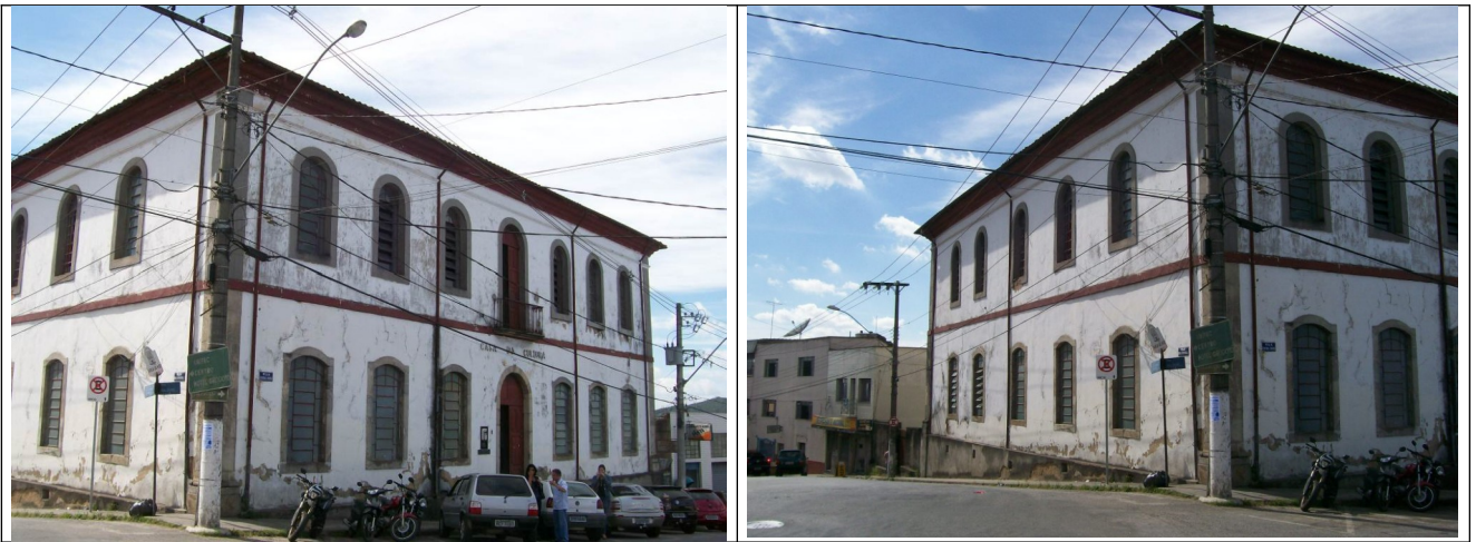
Figuras 08 e 09 – Fachadas do imóvel.
