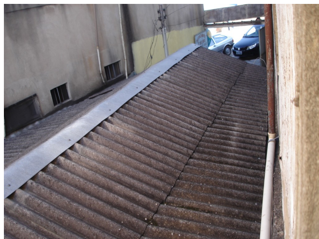
Figura 19 – Cobertura da construção irregular.
