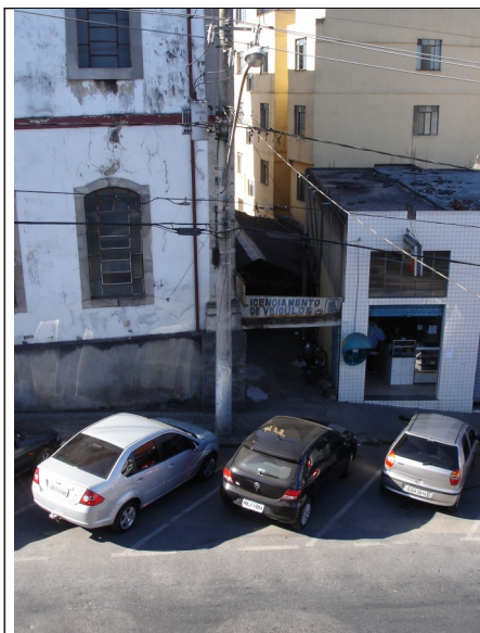
Figura 18 – Vista superior da construção irregular.
