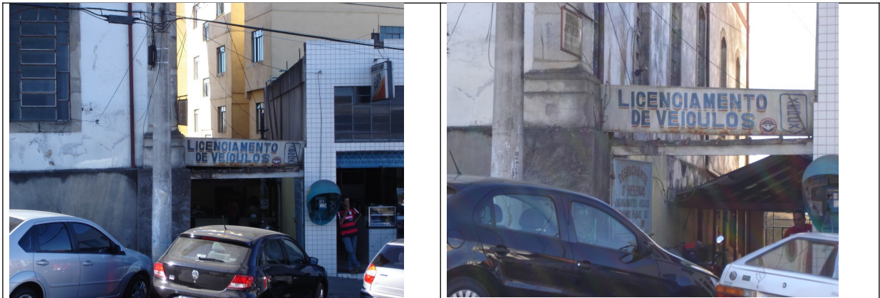
Figuras 16 e 17 – Construção irregular ao lado da edificação tombada.
