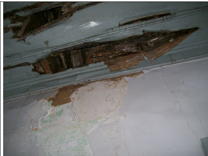
Figura 26 – Forro danificado.
