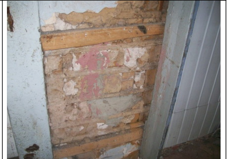
Figuras 16 e 17 – Desprendimento do reboco.
