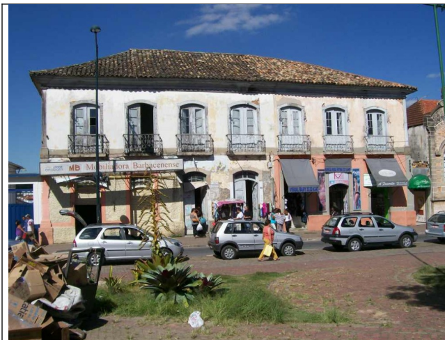
Figura 09 – Fachada principal da edificação.
