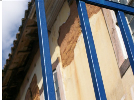
Figuras 16 e 17 – Desprendimento do reboco.
