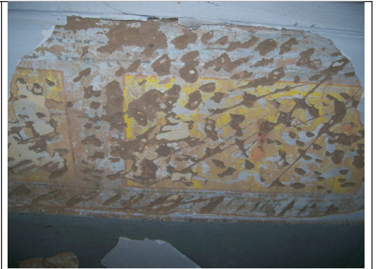
Figura 25 – Pintura decorativa sob reboco.
