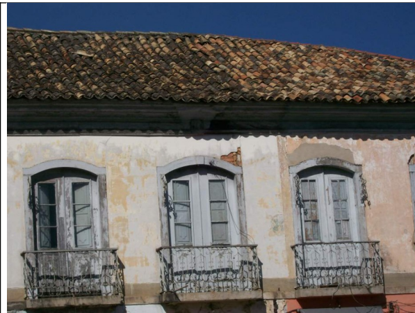
Figura 18 – Vista do telhado onde se percebe trecho que foi recuperado à direita.
