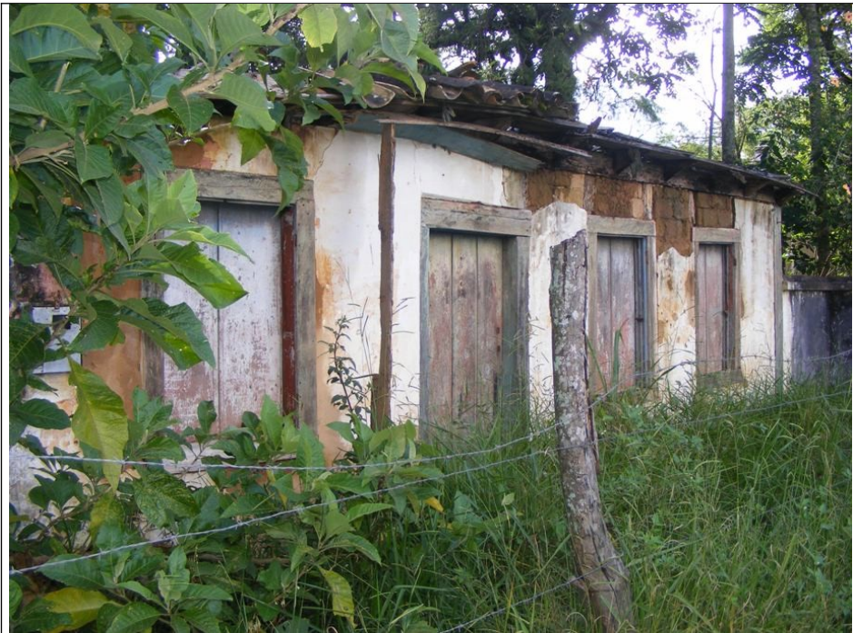
Figura 06 – Fachada principal do imóvel colonial.
