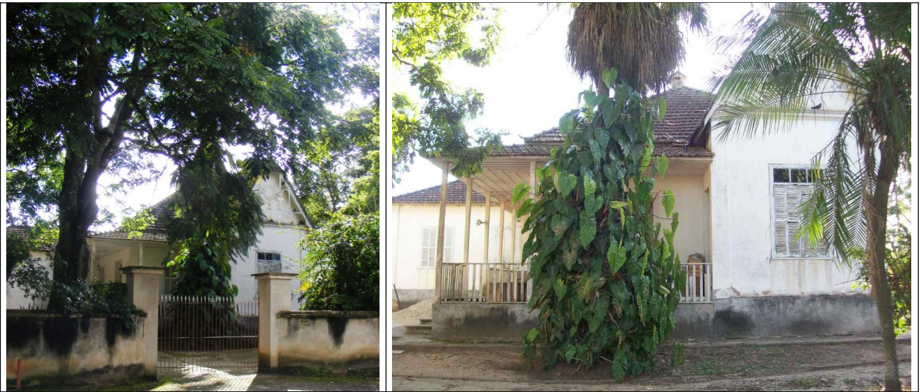
Figuras 10 e 11 – Fachada principal.
