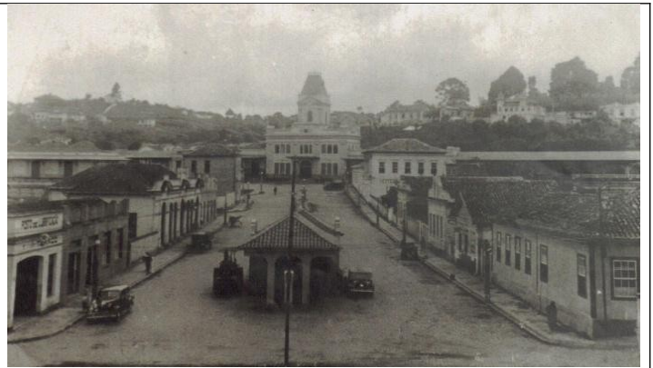
Figura 09 – Posto de gasolina e Praça da Estação em 1930
