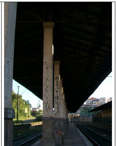
Figura 26 – Inscrições nos pilares das plataformas.
