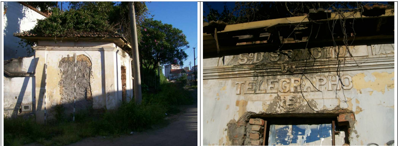
Figuras 29 e 30 – Imagens do Posto do Telégrafo em total estado de abandono.
