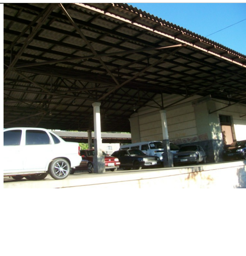
Figura 25 – Estacionamento de veículos em uma das plataformas.
