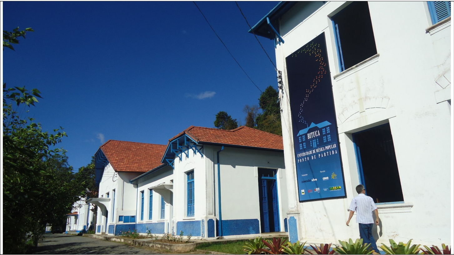
Figura 06 – Vista geral dos prédios já restaurados da Estação Sericicultura.
