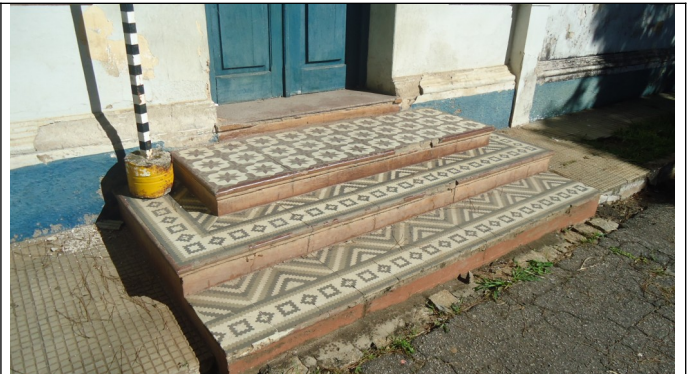
Figura 08 – Escada de acesso ao prédio.
