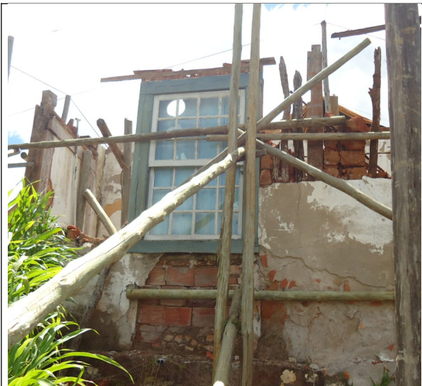
Figura 14 – Desfazimento do barro e da trama de madeira do pau a pique.
