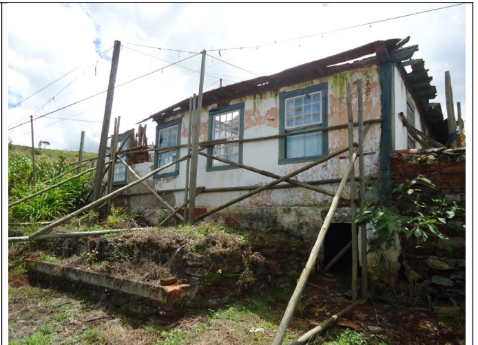
Figura 02 – Imagem fachada lateral esquerda.
