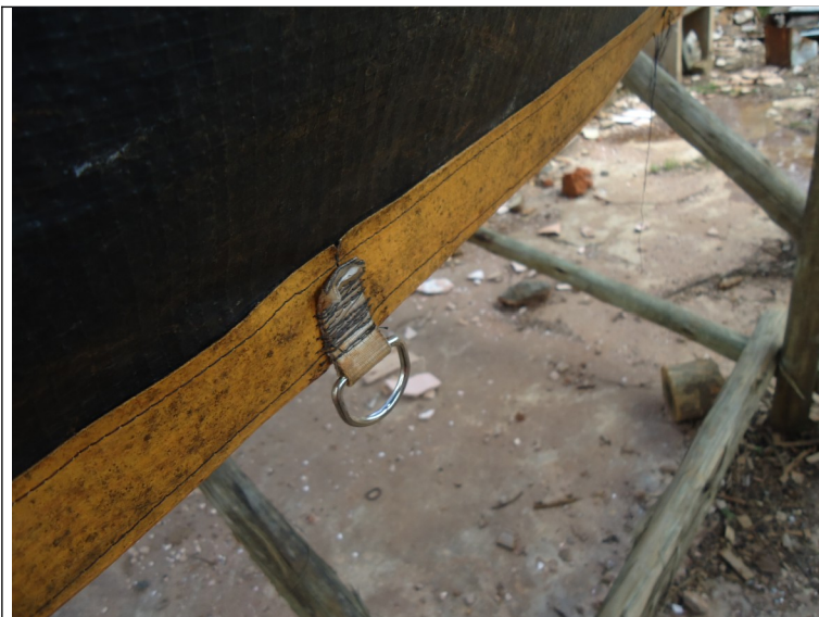
Figura 18 – Reforço no elemento de fixação da lona feito pela empresa de engenharia ...
