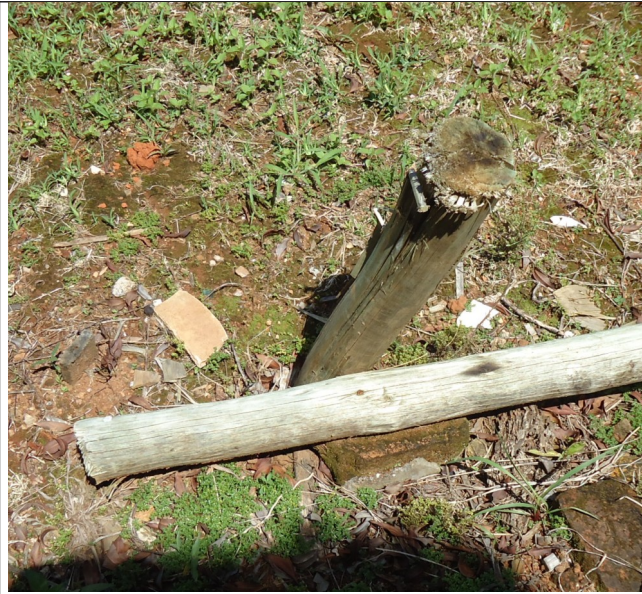
Figura 12 – Escora solta da estaca chumbada no piso.
