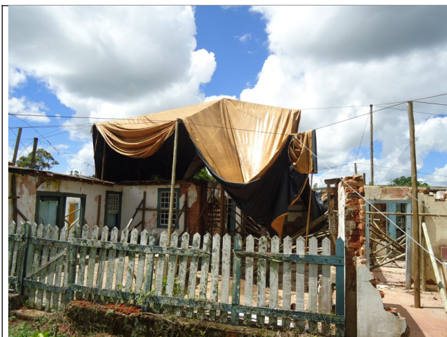
Figura 03 – Imagem fachada posterior.
