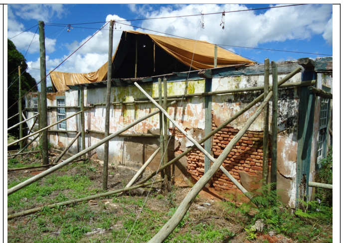
Figura 04 – Imagem fachada lateral direita.
