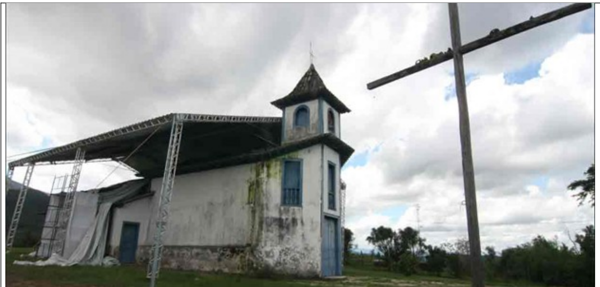
Figura 20 – Enquanto aguarda obras de restauração, Capela de Santa Quitéria, do século 18, em Catas Altas, é coberta com estrutura metálica para evitar maior degradação
