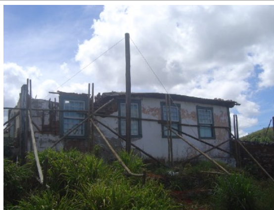
Figura 10 – Escoramento estrutura de madeira e cabos de aço para receber lonamento.
