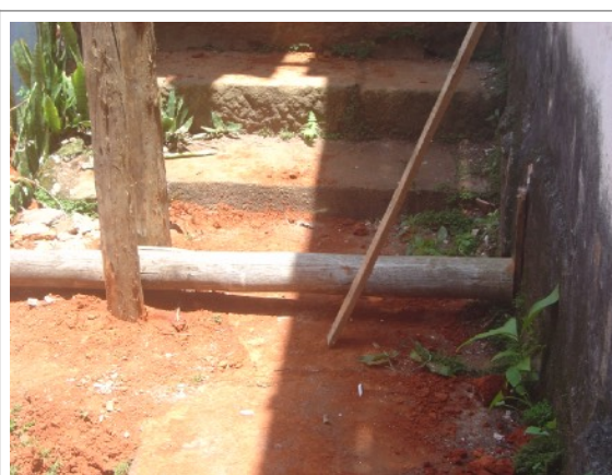
Figura 08 – Escoramento do lado externo
