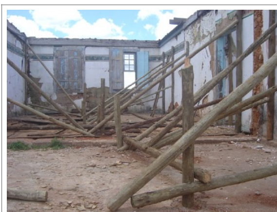
Figura 07 – Escoramento do lado interno
