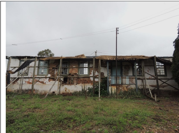
Figura 01 – Fachada frontal da edificação
