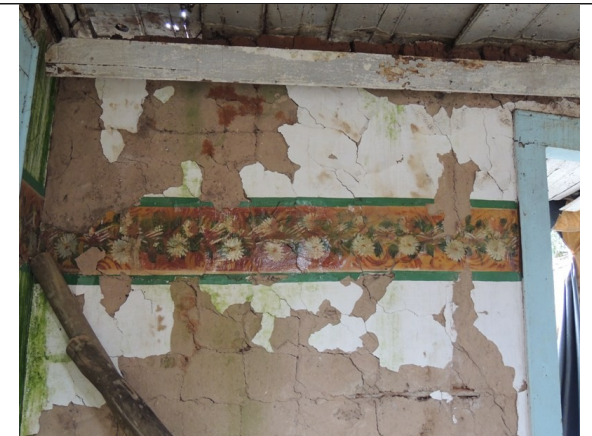
Figura 04 – Vista interna do imóvel.
