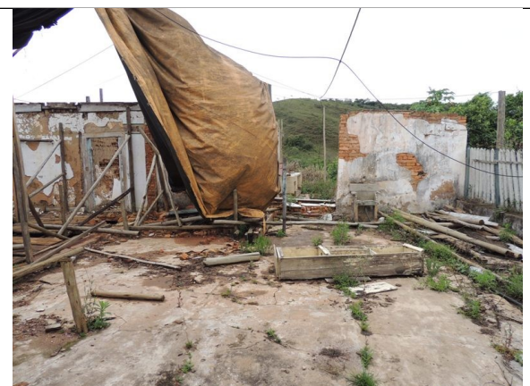
Figura 06 – Vista de parte interna do imóvel.
