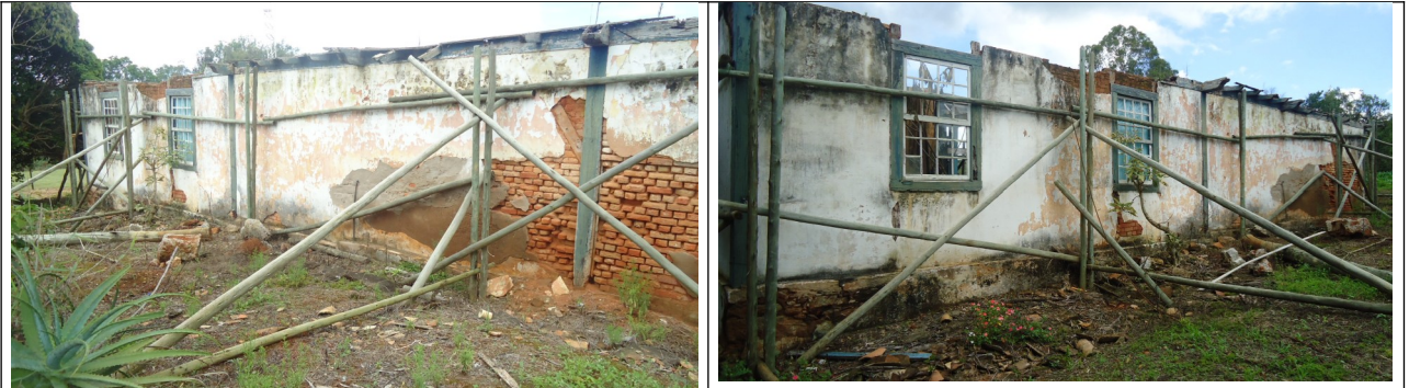
Figuras 15 e 16 – Fachada lateral direita.
