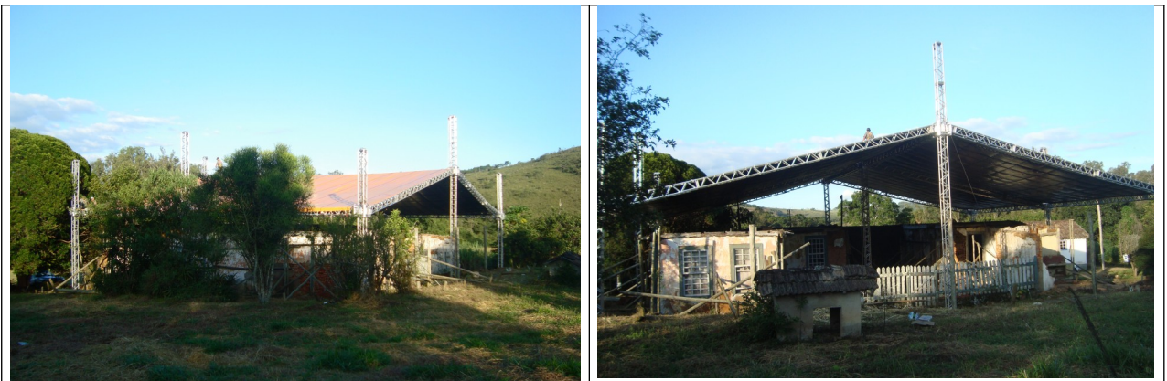
Figuras 01 e 02 – Imagens da estrutura montada sobre a Fazenda do Registro.
