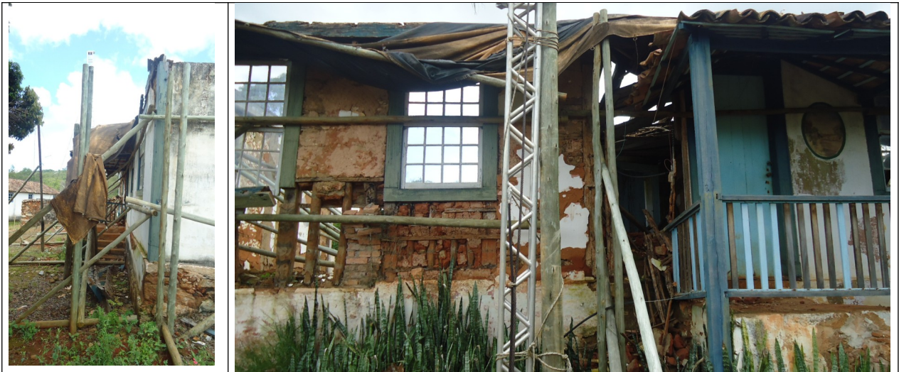
Figuras 17 e 18 – Fachada frontal.
