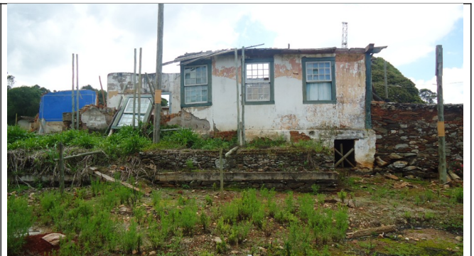
Figura 12 – Fachada lateral esquerda.
