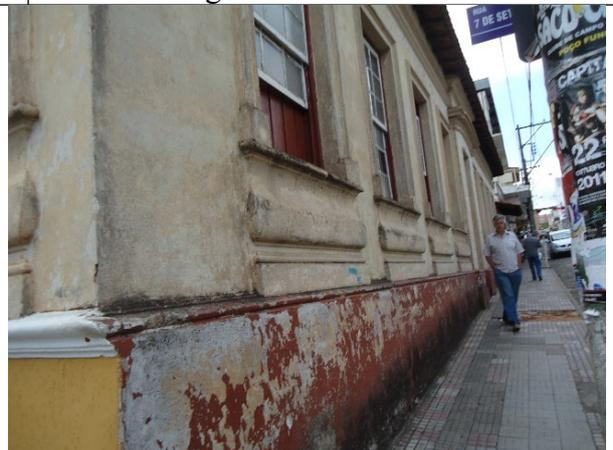
Figura 09 – Manchas de umidade e descolamento da camada pictórica.
