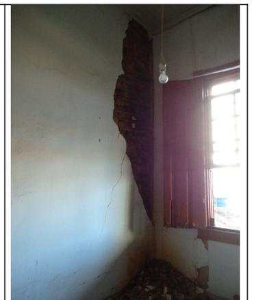
Figura 12 – Trincas e descolamento do reboco.
