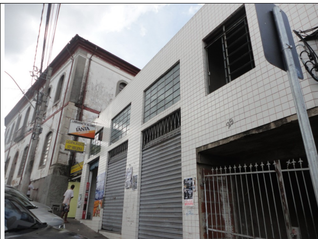
Figura 12 – Edificação comercial à rua General Câmara nº 29 – trecho frontal. Fonte: Fotos de Sérgio Campelo – abril 2013.
