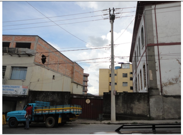
Figura 15 – Construção na rua General Hernane Rabelo nº 61.
