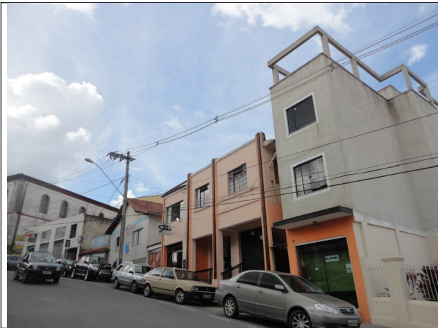
Figura 14 - Construção na rua General Câmara nº 59.
