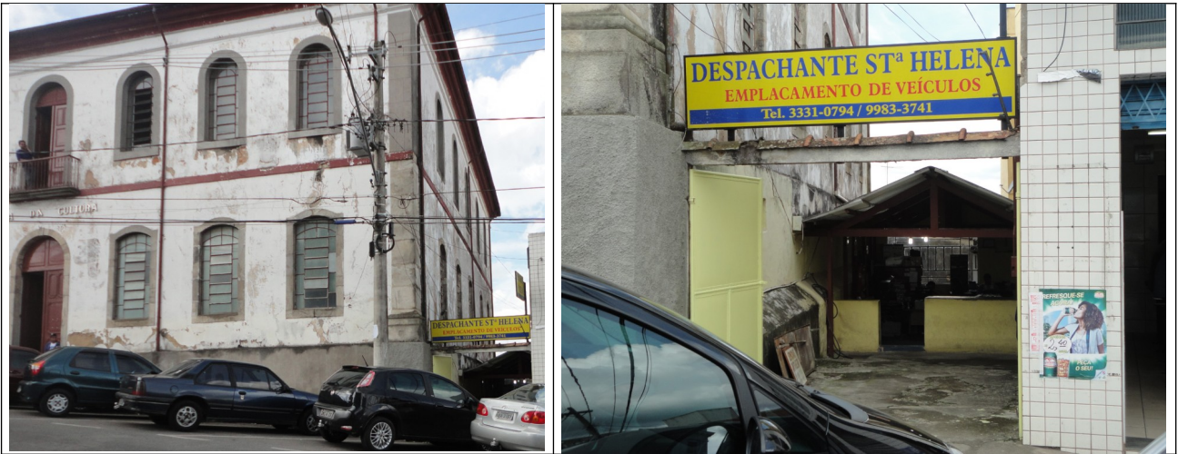
Figuras 10 e 11 - Construção irregular existente no “beco” perpendicular à rua General Câmara – vista geral e detalhe. Fonte: Fotos de Sérgio Campelo – abril 2013.
